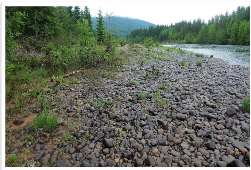
Figur 25 Stora mängder uppschaktat lekgrus. När gruset läggs ut i älven ökar arealen lek område men automatiskt även bredden, vilket skapar större och bättre uppväxtytter för bottenfauna och fisk.
