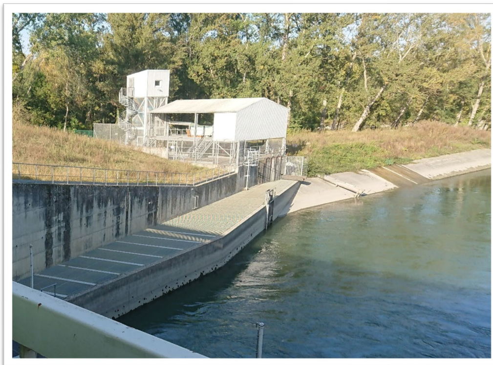
Figur 50 Oppsamlingsanordning for oppvandrende fisk i elva Garonne i Frankrike. Foto: Länsstyrelsen Värmland.
