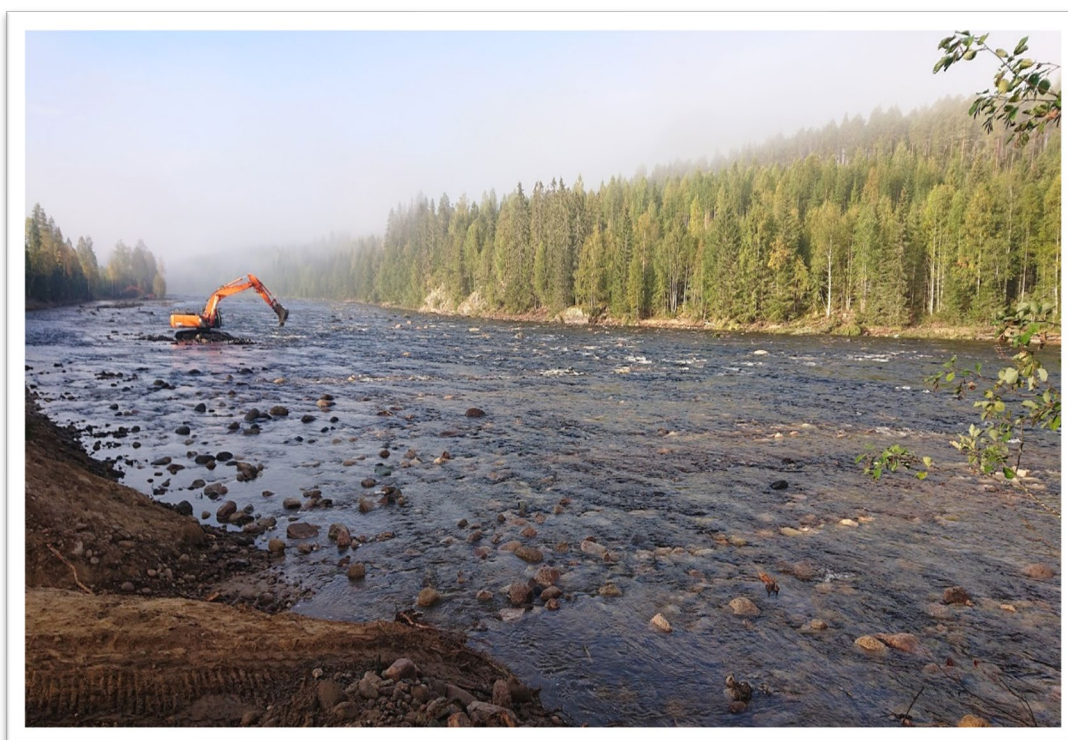
Figur 30 Maskiner i arbete med att lägga ut sten från schaktvallarna längs älvens stränder. Sträckan uppströms grävmaskinen är återställd.
