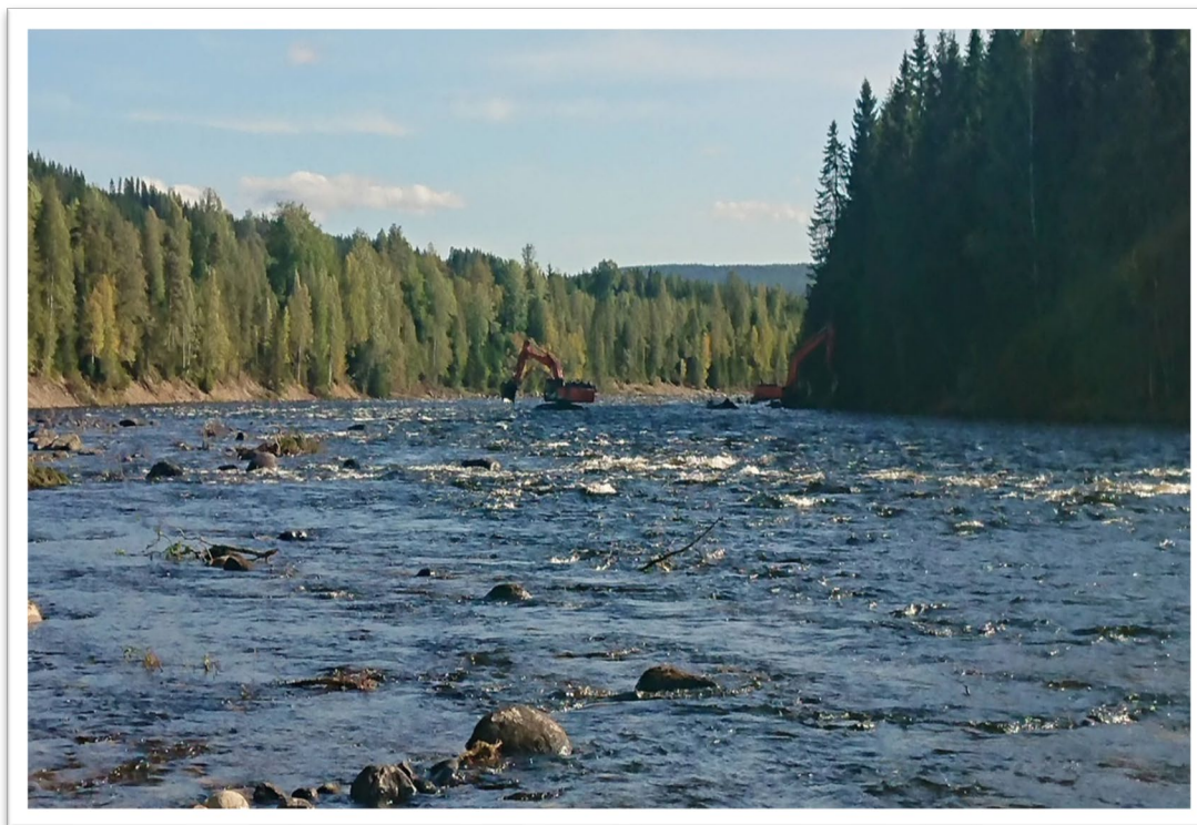
Figur 32 Parti av älven där utlagda block, stenar och lekgrus skapat både lek- och uppväxtområden för lax, öring och harr samt flera nya fiskeplatser.
