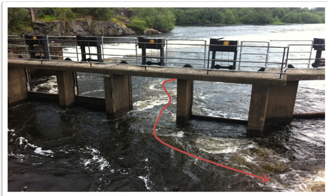
Figur 17 En av ingångarna till fiskvägen vid Forshaga kraftverk. Röd linje visar där fisken vandrar från älven och in i fiskvägen. Foto: Länsstyrelsen Värmland.
