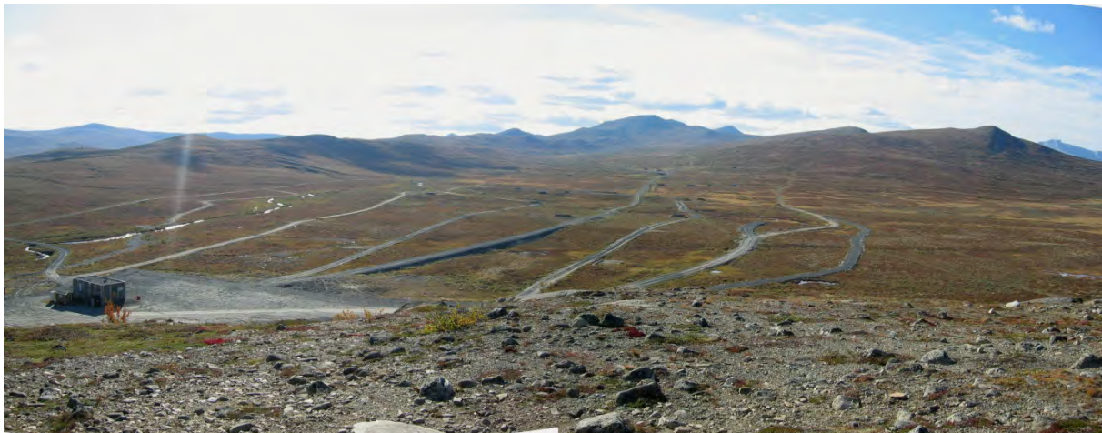
Figur 8. Framrykningstraseer m.v. ved Haukberget 1 før tilbakeføring. Bildet er tatt i 2004 (foto: Forsvarsbygg).
