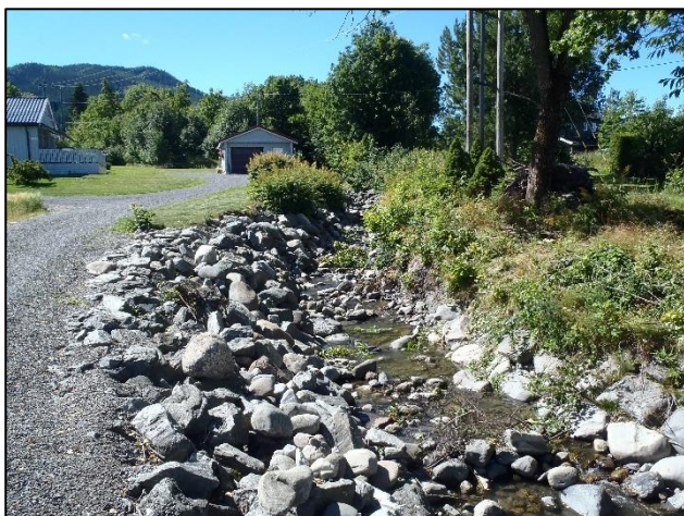
Hammerstadelva ovenfor kulvert Fv. 33.
