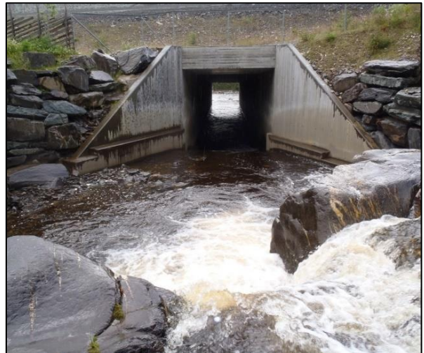
Kulvert ved stasjon 3.
