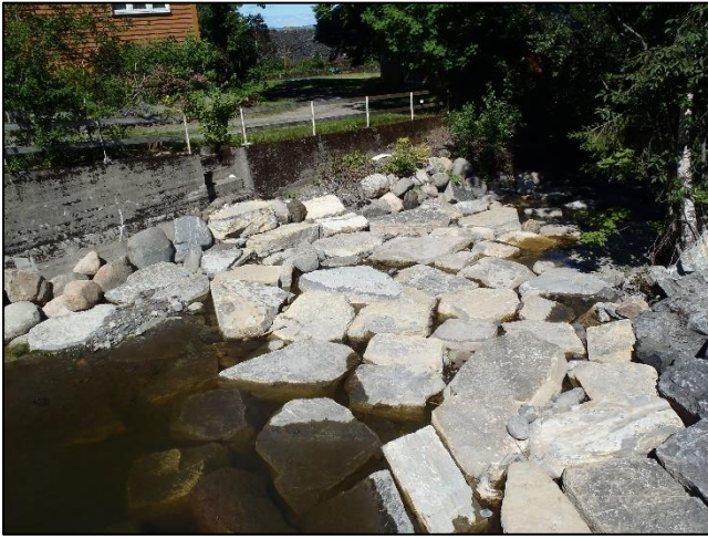
Nedstrøms kulvert fv. 33.
