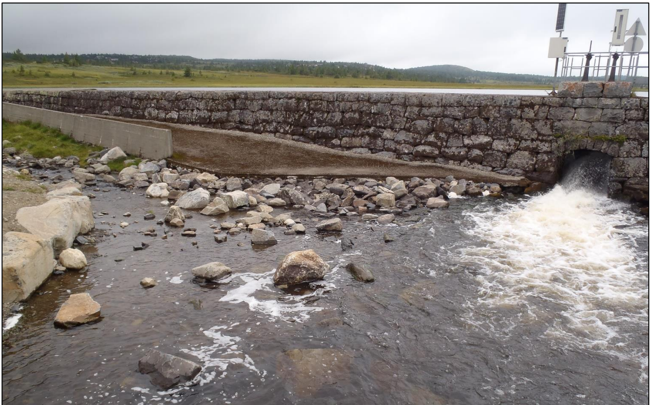
Figur 34: Del av dammen ved Kroksjøen, med nedre del av fiskerenna til venstre i bildet.
