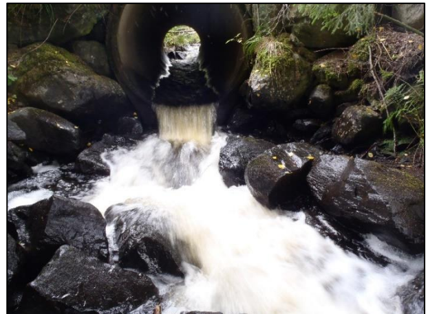
Figur 74: Kvernbekken, kulvert under Næravegen
