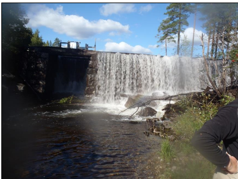
Demning ved utløpet til Søre Buvatnet.
