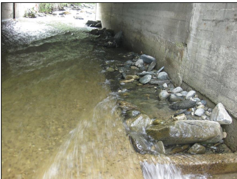
Rolla i tunnel under E6, med fiskerenna som er fylt opp med sedimenter til høyre.
