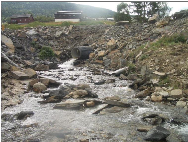
Skurdalsåa ved anleggsområde for ny E6.
