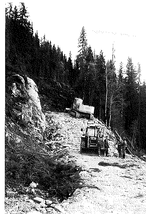
Veibygging i vanskelig terreng i Husvollia i Stor-Elvdal.
