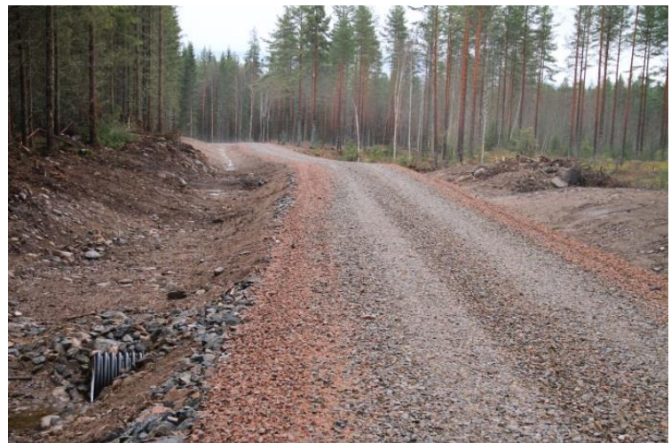
Samme vegen ferdig ombygd
