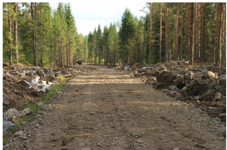
Ombygging av veg med mye stein i overflata og oppe på bakken
