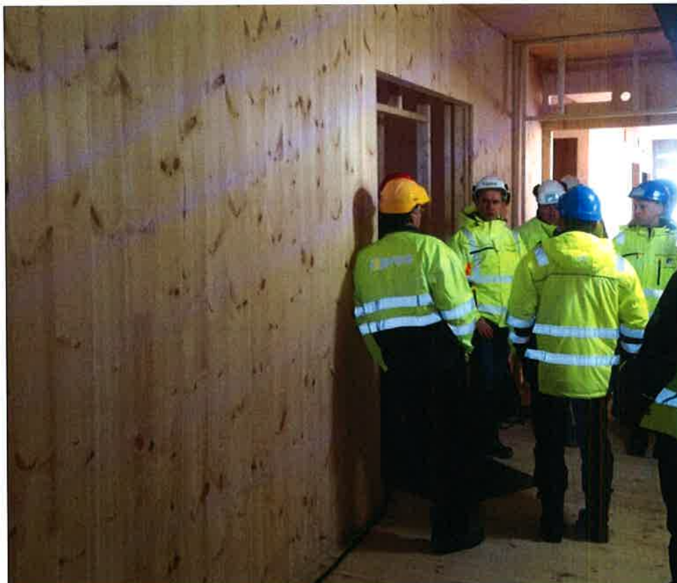
Fra omsorgsbolig i massivtre under bygging i Lillehammer. Fotograf: Kjell Joar Rognstad / Fylkesmannen i Oppland
