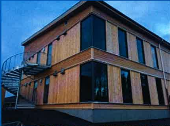
Hanstad skole; Elverum, moduler i massivtre. Ferdig til skolestart høsten 2017. Foto: Hans Erik Skarfi.
