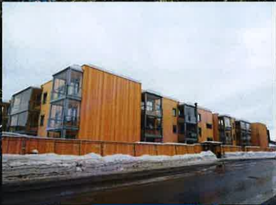
Gartnerhagen omsorgsleiligheter på Lillehammer. Bygd i massivtre og med passivhusstandard. Foto: Treindustrien.
