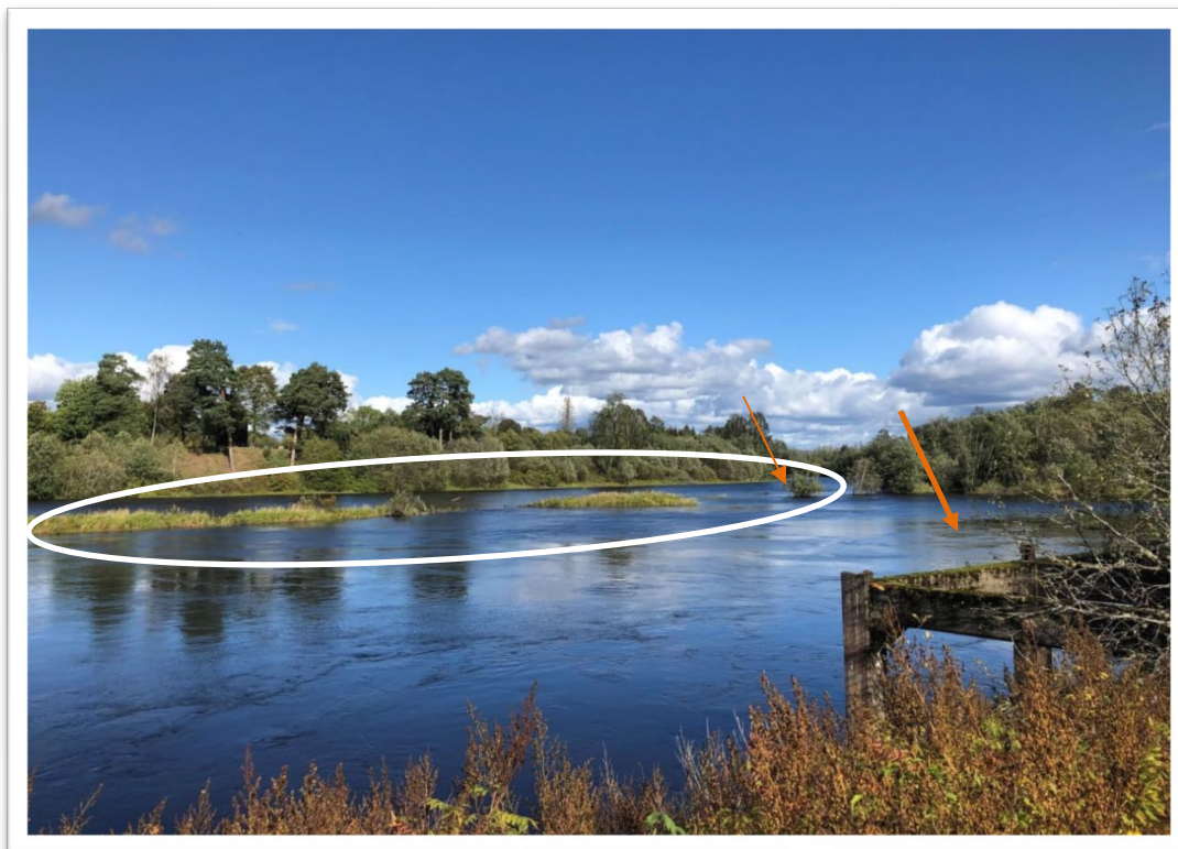
Figur 34 Delar av den befintliga jordövertäckta och gräsbeväxta Stenledaren (vit markering). Nedströms stenledaren delar älven upp sig i två grenar, dels Ådran (tunn orange pil) som rinner i nordostlig riktning till sjön Lusten, dels huvudfåran (fet orange pil). Vid fototillfället uppgick vattenföringen till ca 340 m 3 /sekund, vilket är ca 64% av medelhögvattenföring (MHQ). Modifierad efter foto från SMHI.
