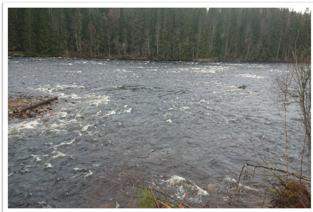
Figur 31 Ett återställt parti av älven strax söder om Spisängen där både block, sten och lekgrus lagts ut. Även en ö (skymtar till vänster i bild) har tillkommit av resterna från den gamla ledarmen efter flottningen.
