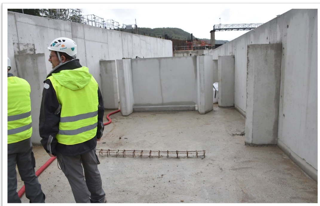
Figur 15 En stor fiskpassage (dubbelslits) under konstruktion vid ett av de besökta kraftverken. Foto: Statsforvalteren i Innlandet.
