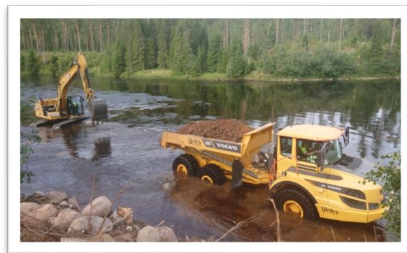
Figur 29 Maskiner i arbete med att lägga ut lekgrus uppströms Strängsforsen.
