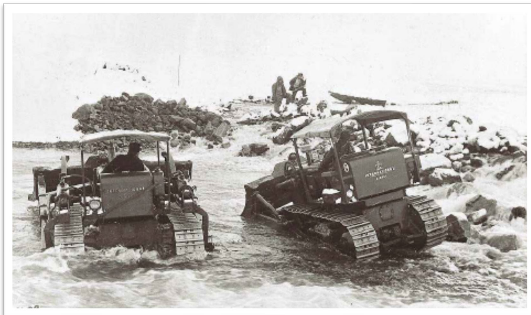
Figur 9 Flottningsrensning med bulldozer. Foto Johan Brun.
