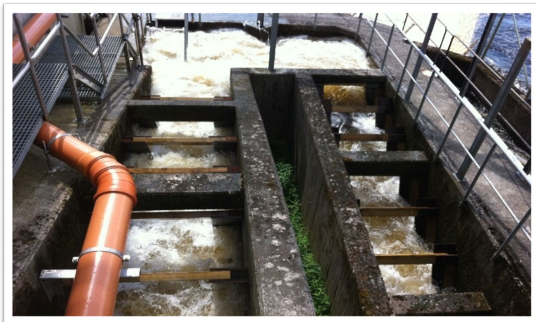
Figur 18 Del av dagens fiskväg (denilränna). Till höger skymtar den nedre delen av fiskvägen (kammarrappa). Till vänster i bilden syns röret som leder fisken från fiskvägens övre del till avelsbassängen. Foto: Länsstyrelsen Värmland
