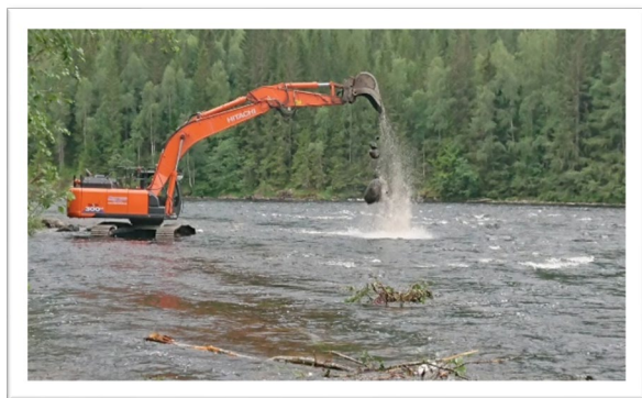
Figur 28 Maskin i arbete med att lägga ut sten uppströms Strängsforsen.
