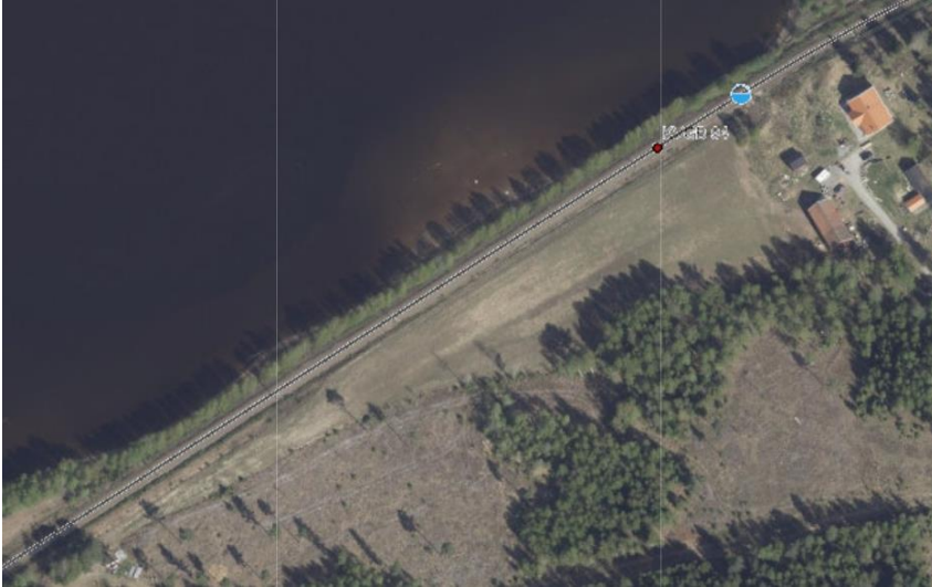
Figur 5. Av rør og kabler i området er det ikke identifisert andre ting enn stikkrennene som krysser jernbanen. Plasseringen er indikert med blå symboler på utklippene som er hentet fra Banekart.no. De aktuelle stikkrennene vil bli forlenget/skiftet ut.
