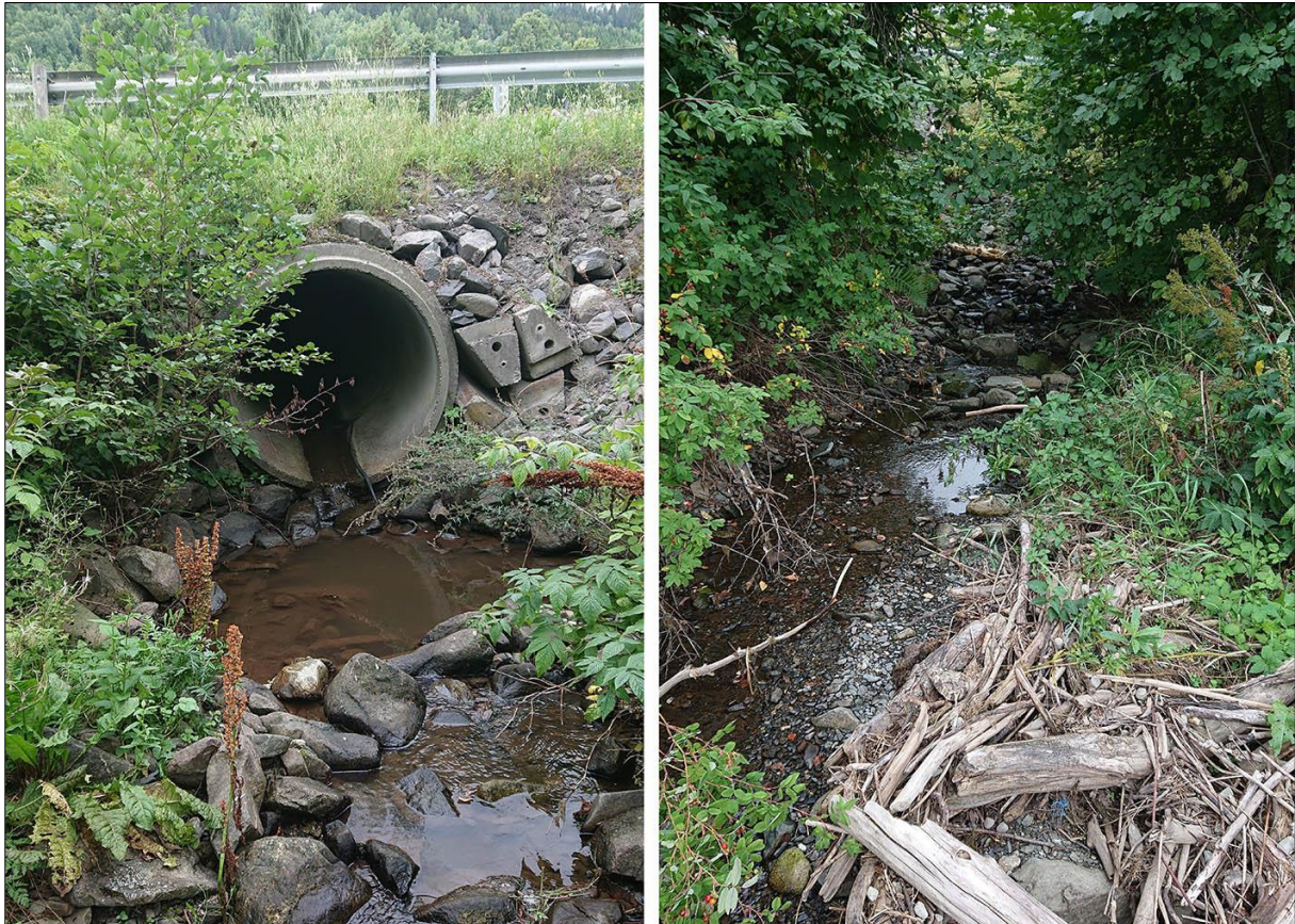
Figur 35. Bulungsbekken går i stikkrenne under dagens E6.
