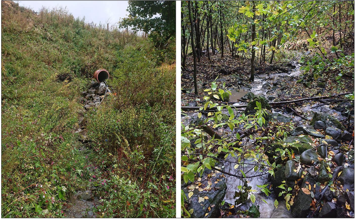
Figur 11. Mælumsbekken går i stikkrenne under dagens E6.
