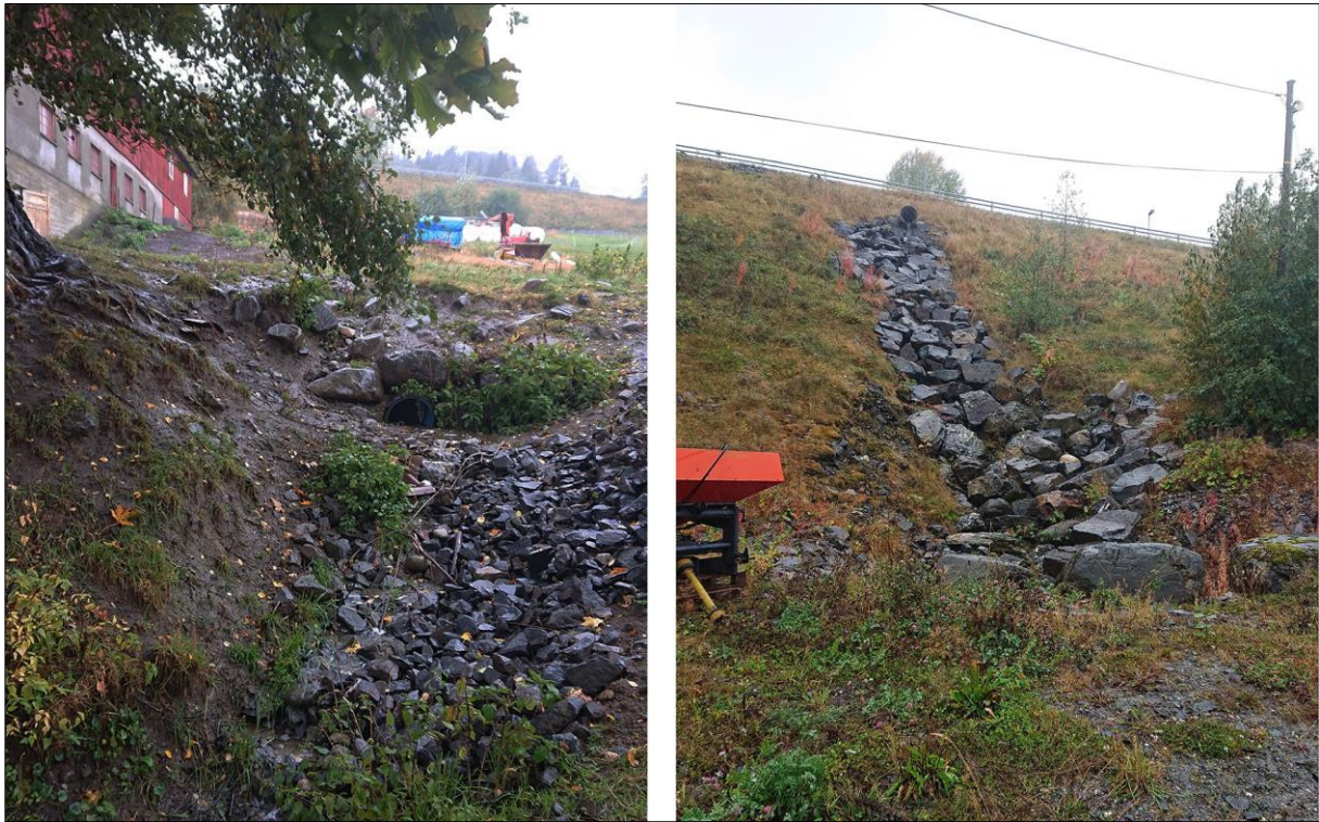
Figur 6. Roterudbekken passerer Roterud gård og ligger i en hengende rørkulvert under dagens E6.
