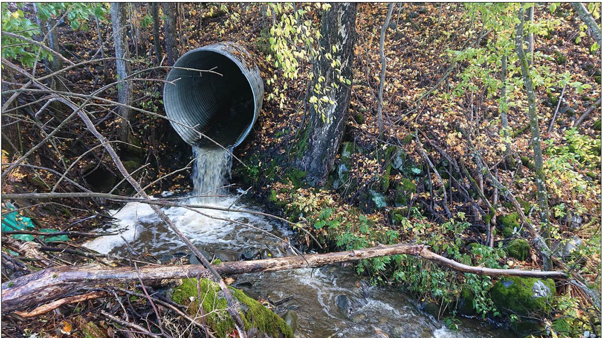
Figur 16. Funksjon for fisk er redusert i Finstadbekken pr. i dag grunnet vandringshinder under dagens E6..
