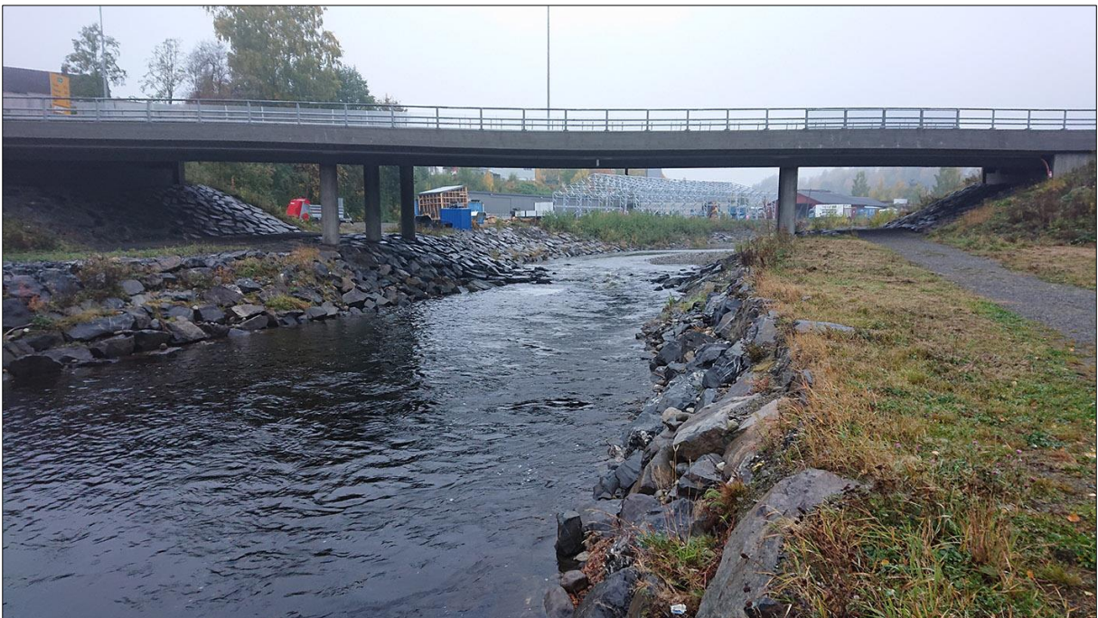
Figur 29. Nedre del av Rinna med dagens E6-krysning er sterkt preget av flomsikringstiltak.
