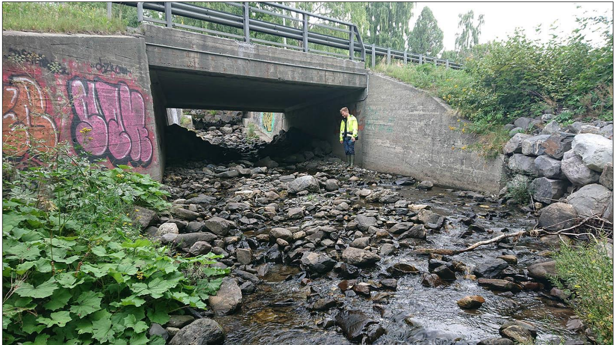
Figur 38. Oppstrøms kulvert med dagens E6-krysning i Øyresbekken. På bildet ser vi kulvert under dagens fylkesveg.
