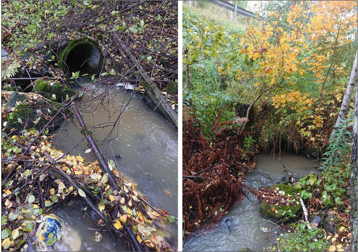
Figur 23. Iversbekken går i stikkrenne under dagens E6.
