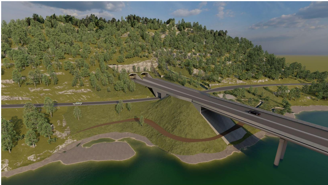
Figur 30: Illustrasjon av fylling under søndre landkar Lågen bru.
