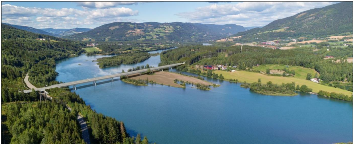
Figur 9. Lågen bru i justert linje, betongkassebru.
