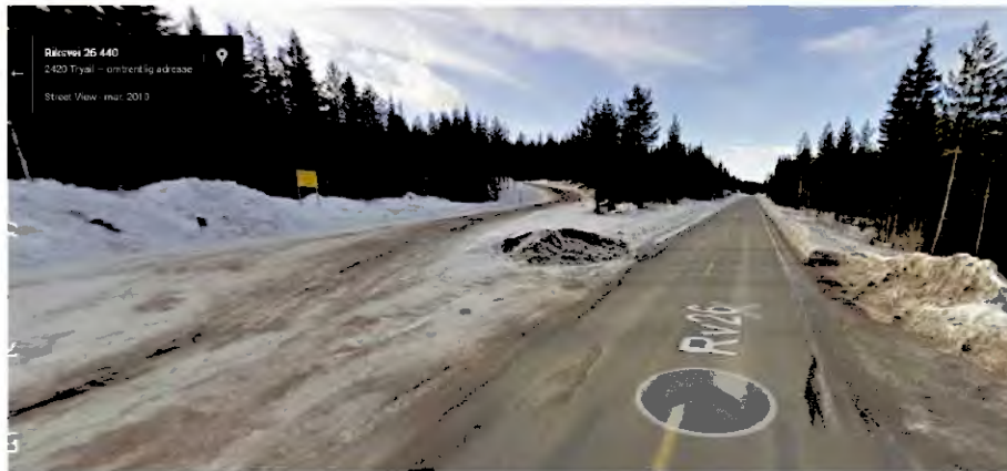
Figur 10. Fylkesveg 26 og avkjørsel til Høgåsen massetak sett sør fra.
