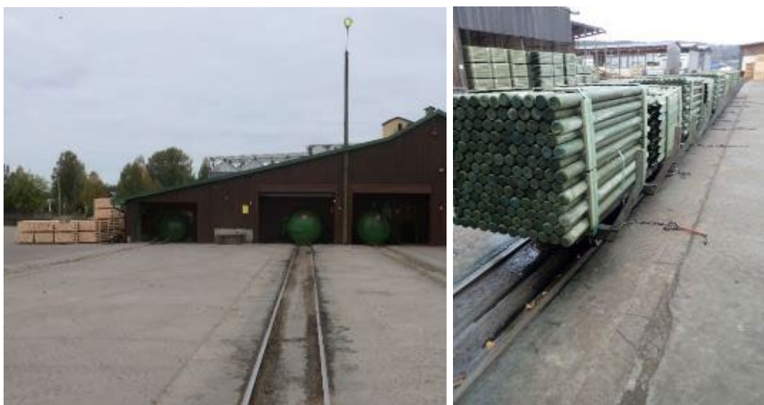
Figur 2-3. Impregneringstank og området hvor treverket drypper av seg etter impregnering.
