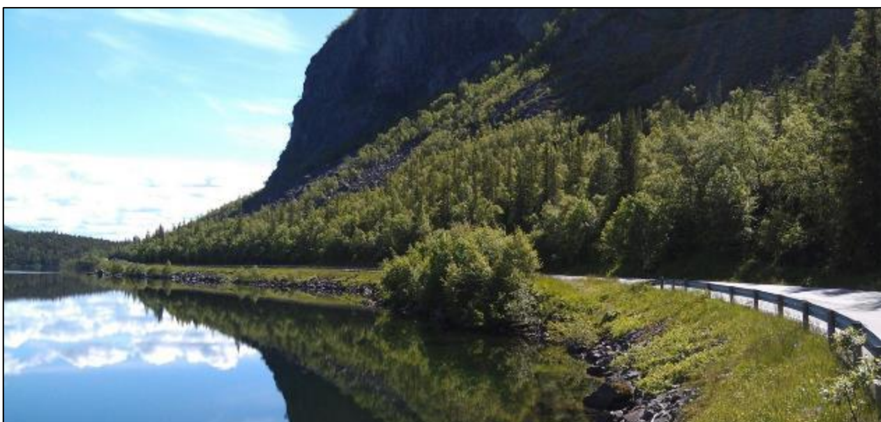
Figur 2: Dagens E16-fylling ut i Norsvinsfjorden i Hugavike, fotografert mot øst. Skråningen ovenfor vegen domineres av delvis skogdekt ur.
