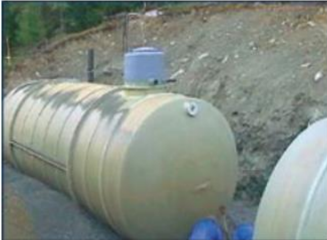
Figur 7: Tanker for sedimentering av vaskevann.
