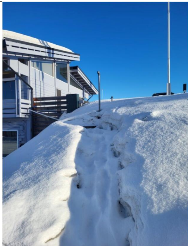
Lufteør nedgravd dieseltank
