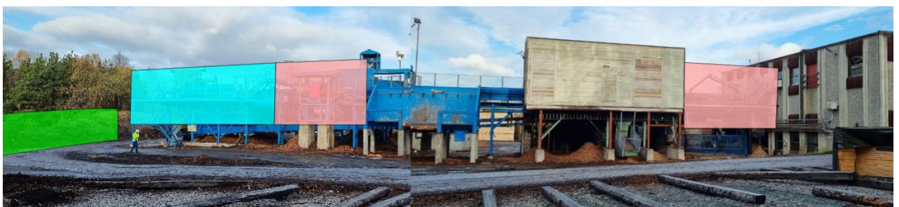
Figur 9. Illustrasjon av skjermingstiltaket. Grønn figur viser heving av eksisterende voll til ca. 3,5 meter i forhold til veien. Lyseblå figur viser støyskjerm på inntaket som skjerner for deler av maskinen i høyden. Røde figurer viser supplerende støyskjerner. Fra Norconsult sin støyrapport /16/.
