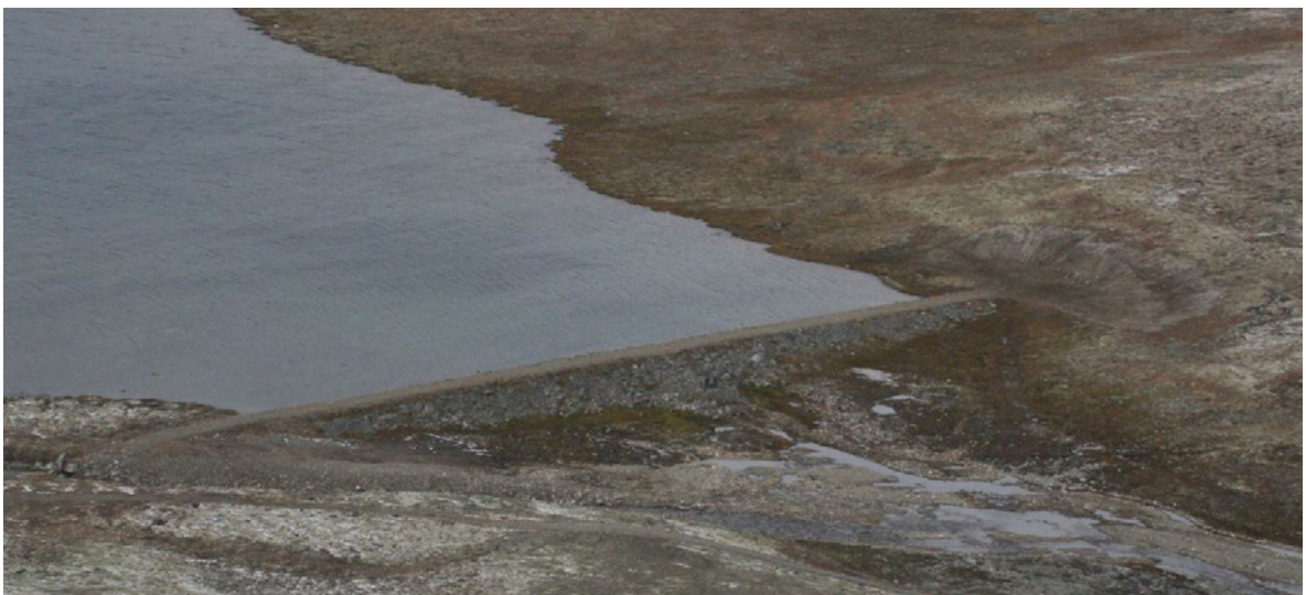
Einøvlingsdammen (ca 150 m) hever Einøvlingsvatnet inntil 1 m over opprinnelig nivå. Foto: Forsvarsbygg.
