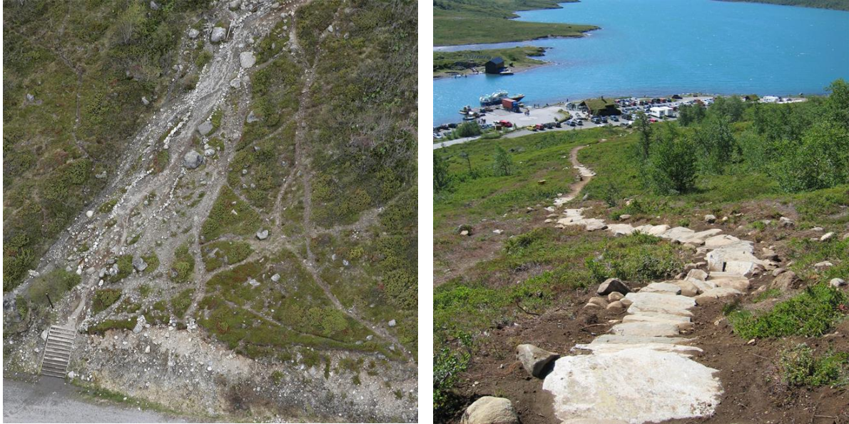
Fig 1. Tiltak på stier med høy ferdsel og slitasje. Erosjon (til venstre) og utførte erosjonssikringstiltak (til høyre) på stien til Besseggen fra Gjendesheim i Vågå (Foto: SNO/Harald Klæbo).
