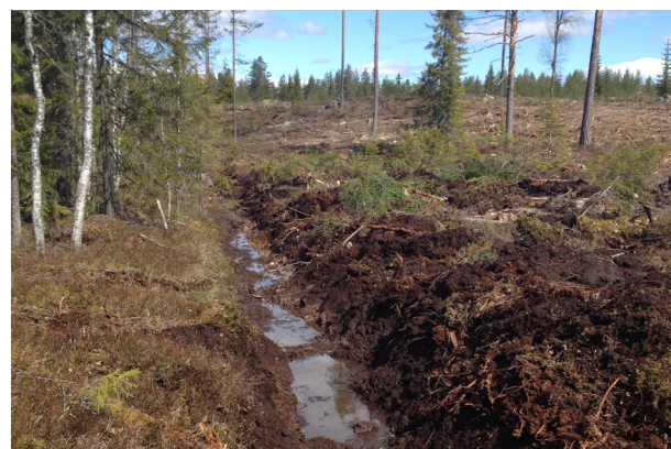
Grøfter skal ikke være dypere eller bredere enn nødvendig.
