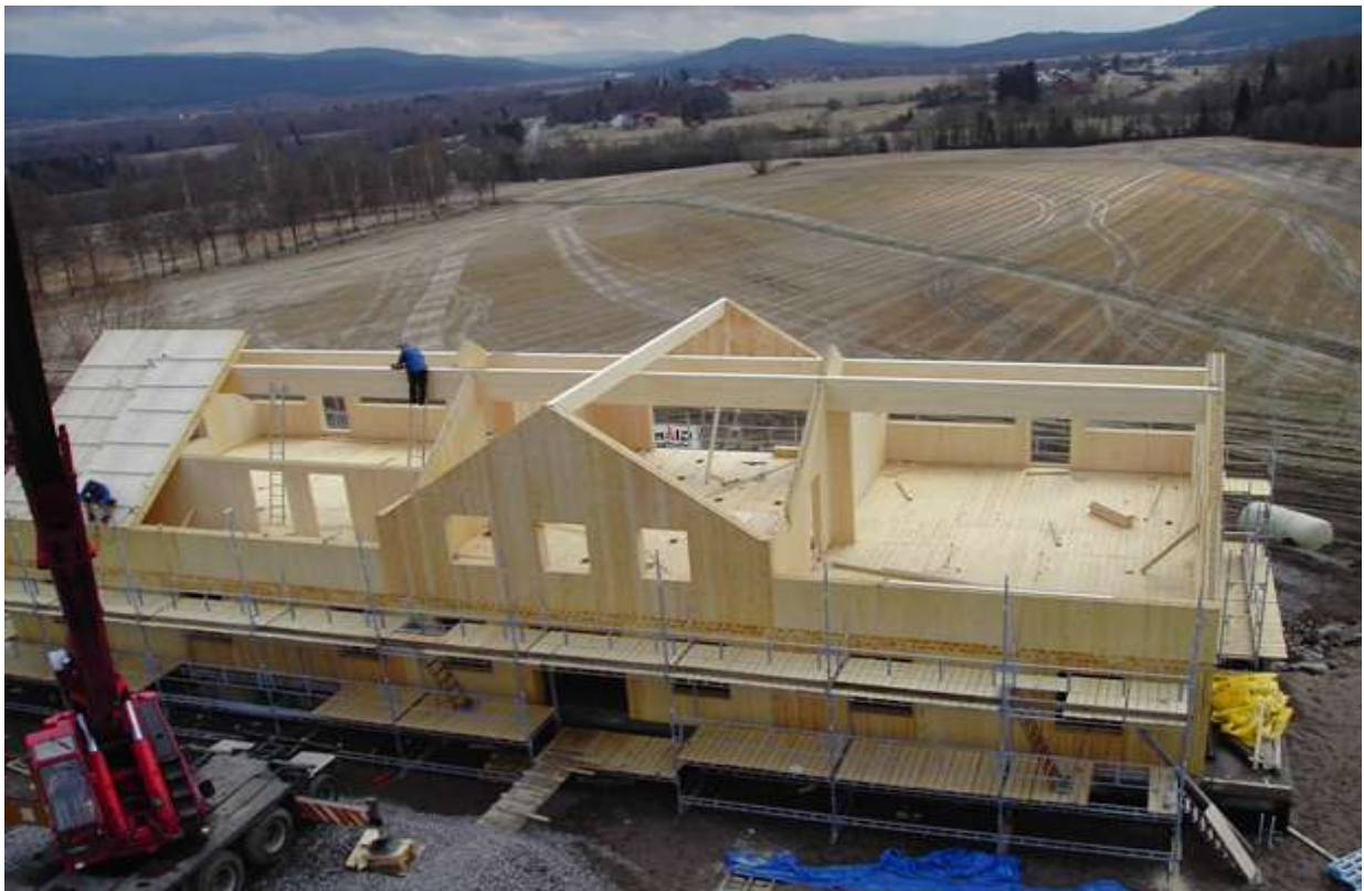
Bygging med massivtre Opaker Gård Grue. Foto: Holz 100 Norge
