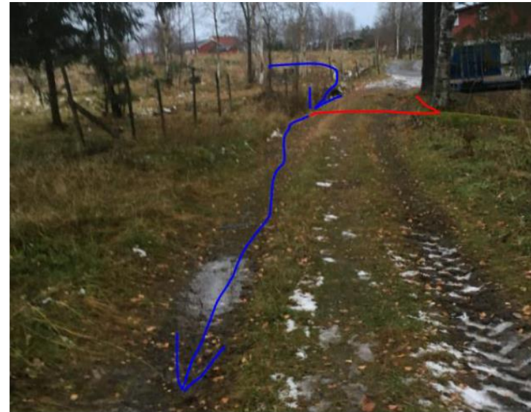
Figur 2. Bekk avmerket med 20 meter sikkerhetssone. Blå pil viser hvilken retning bekken vil ta ved større/ekstreme nedbørsmengder (kartutsnitt fra InnlandsGIS). På bildet til høyre viser blå pil naturlig flomveg mens rød pil viser hvor bekkeløp krysser under veg og videre gjennom boligområdet.
