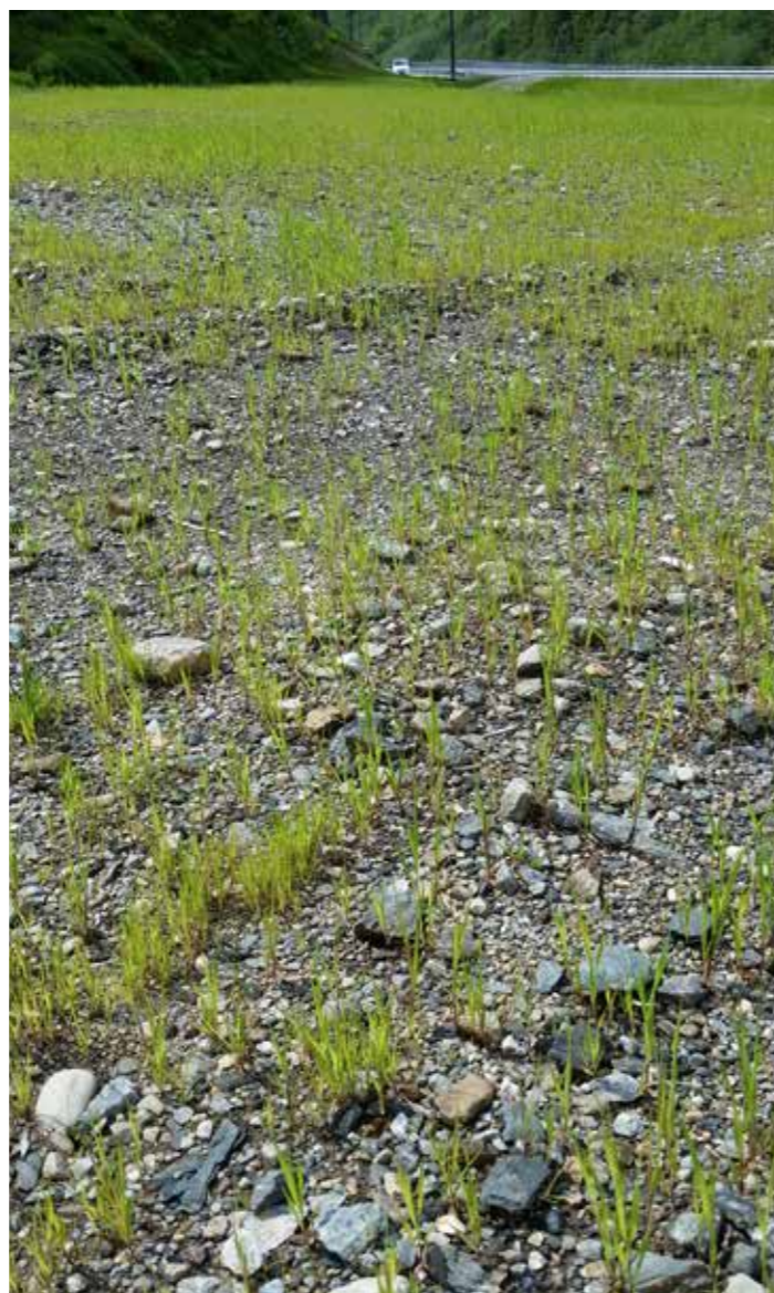
EKSEMPEL PÅ TOPPDEKKE SOM IKKE ER AKSEPTABELT
