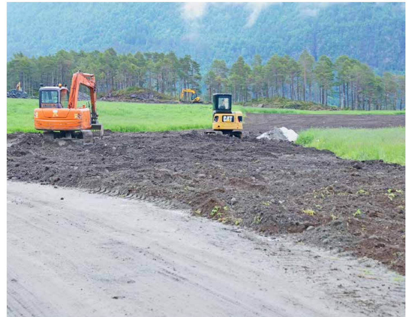
SISTE DEL AV ARBEIDET, MED UTLEGGING AV A-SJIKT ELLER MATJORDLAGET. SMÅ LETTE MASKINAR MINSKAR RISIKOEN FOR SKADELEG OG LANGVARIG PAKKESKADE.
