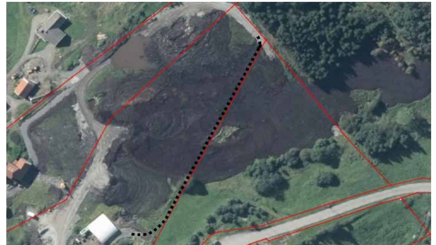
BILETET SYNER STODA RETT ETTER RASET. DEI NEDSTE EIGEDOMANE VAR IKKJE MED PÅ AVTALEN OM MOTTAK AV MASSAR. OM EIN HADDE LAGA EIN KØYREVEG (FLAUMVOLL) SLIK DEN STIPLA LINJA SYNER, VILLE SKADEN HA VORE UNNGÅTT. DENNE VEGEN MÅTTE ISTADEN LAGAS I ETTERTID FOR Å RYDDE OPP.
