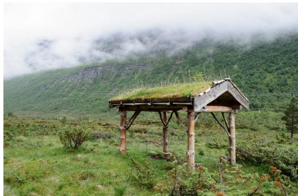
Torvløe. Flott utført arbeid. Foto: Arnold Hoddevik
