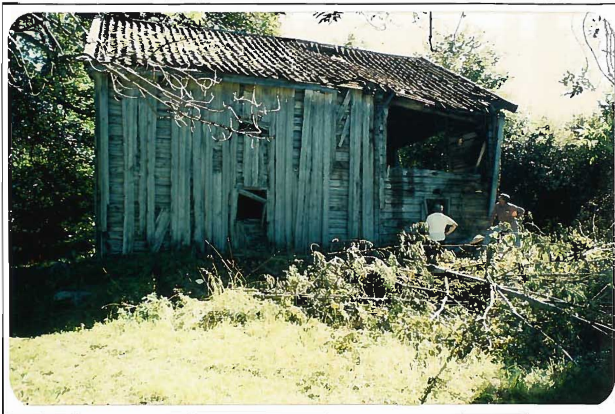
Figur 14. Driftsbygningen før restaurering/nybygg, Veøy.
