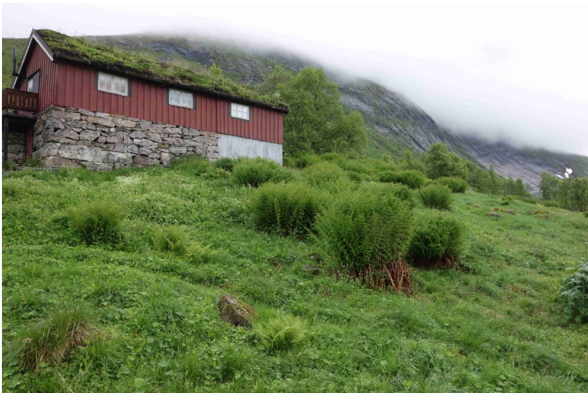
Figur 14. Stølshuset på Kallskarstølen. (Foto; Bioreg AS ©).
