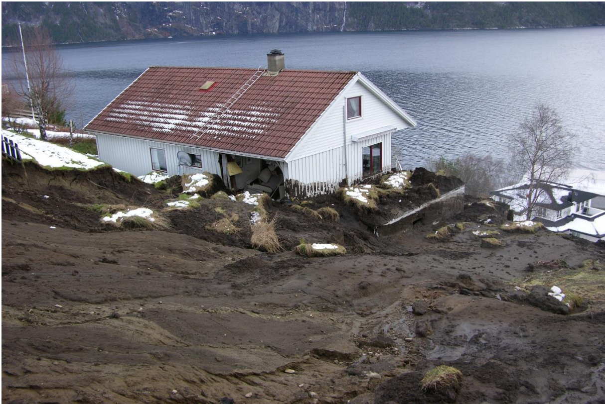
Figur 2.1. Jordskred i Stranda kommune 2008. Foto: FMMR
