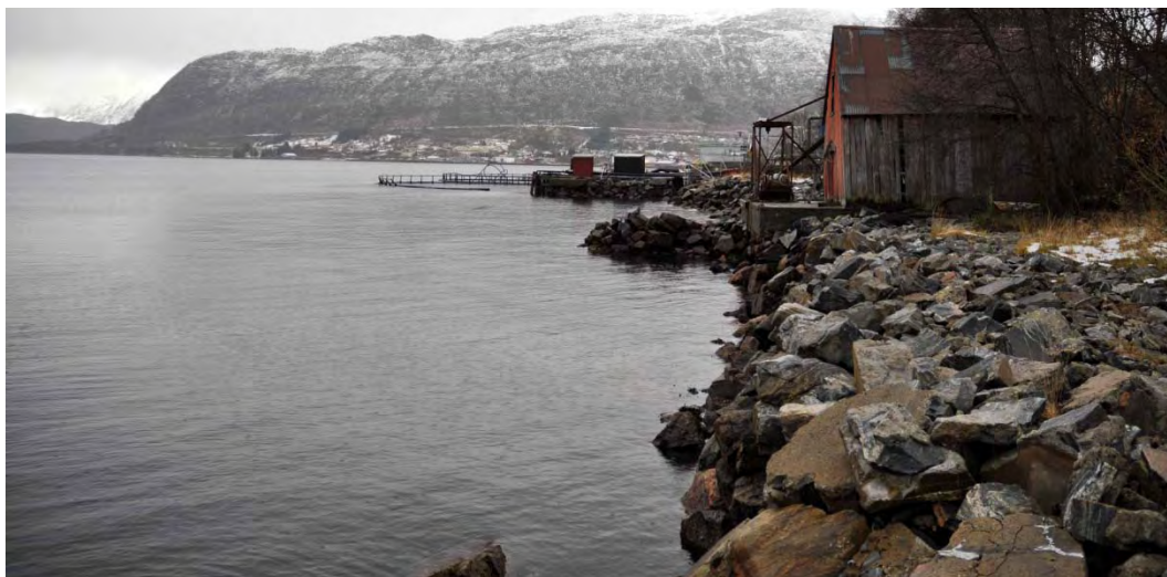
Figur 8: Nordre del av Hareid sentrum. Øvre bilde tatt mot nord, nedre mot sør (mot Hareid sentrum).
