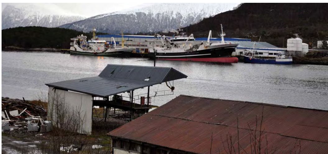
Figur 14: Ytre del av sørsiden av Hjørungavågen.
