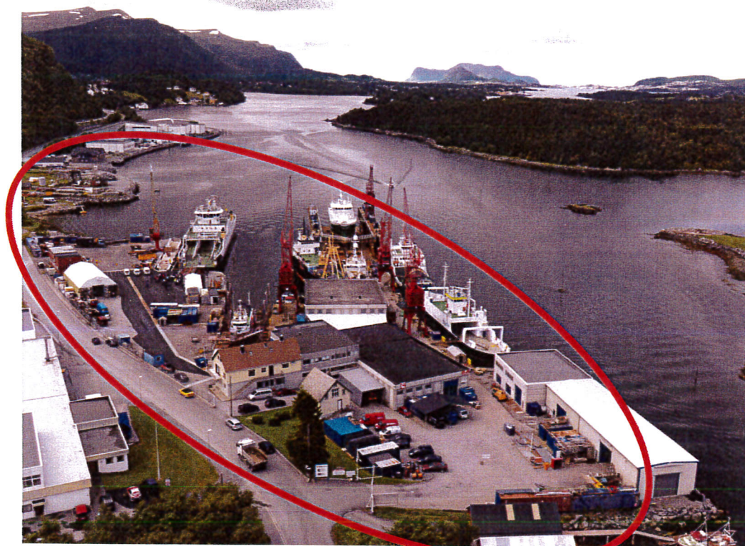
Figur 11: Ved Vegsund Slip AS (mot vest), området hvor tiltak ønskes iverksatt er innringet. Foto: Vegsund Slip AS.
