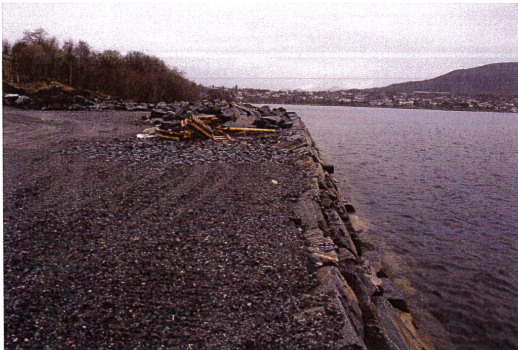
Figur 7: Ved Kvasnes sett mot Vegsund (mot nord). Foto: NGI.
