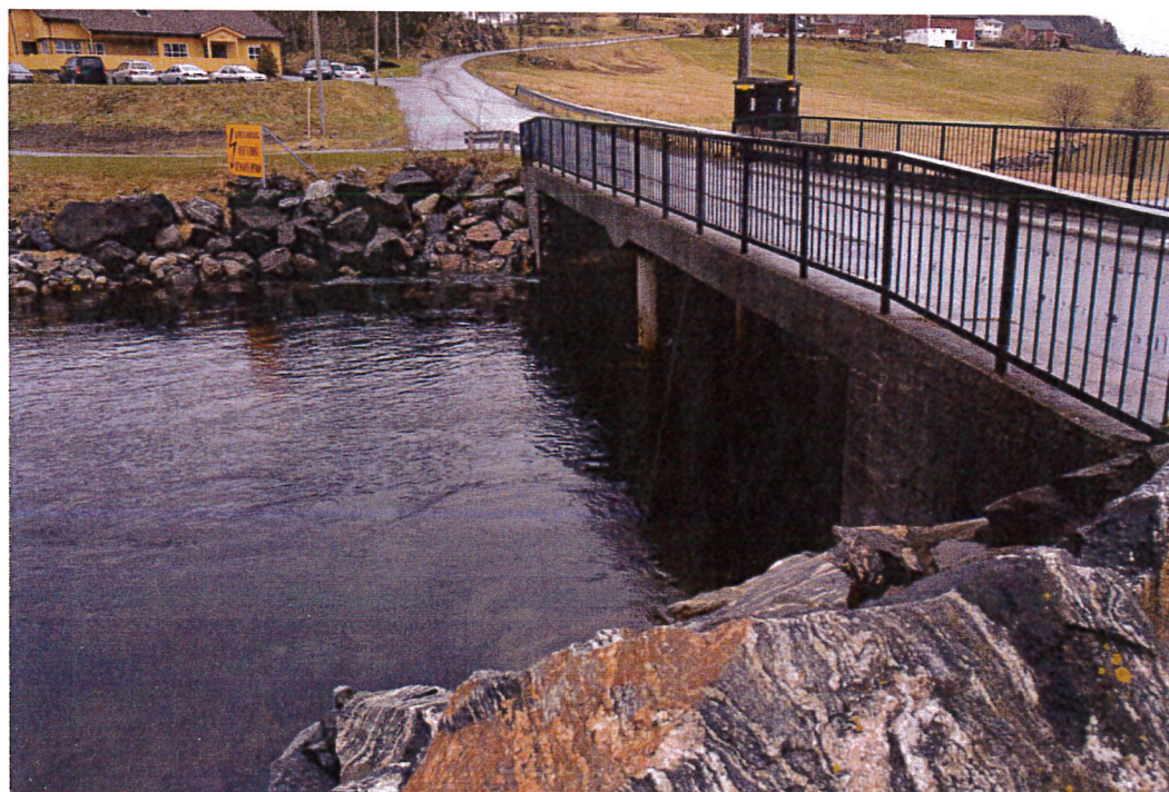
Figur 17: Brua ved Solevågen (mellom fergekai og området for beregning av oppskylling, se Figur 16). Foto: NGI.
