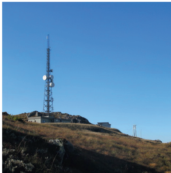
Telelinken oppe på fjellet er et godt synlig landemerke i området, og har gitt navn til området som på folkemunne kalles Linken. Foto: Kjersti Isdal.
