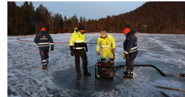
Hamarøy kommune sliter med vannforsyningen. Her pumpes det vann fra Jensvannet over i tanker som fraktes til drukkkevannskilden i Ulvsvåg. FOTO: LARS BJØRN MARTINSEN / NRK
