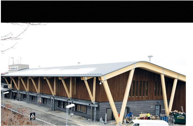
Terminalutvidelse Molde lufthavn
