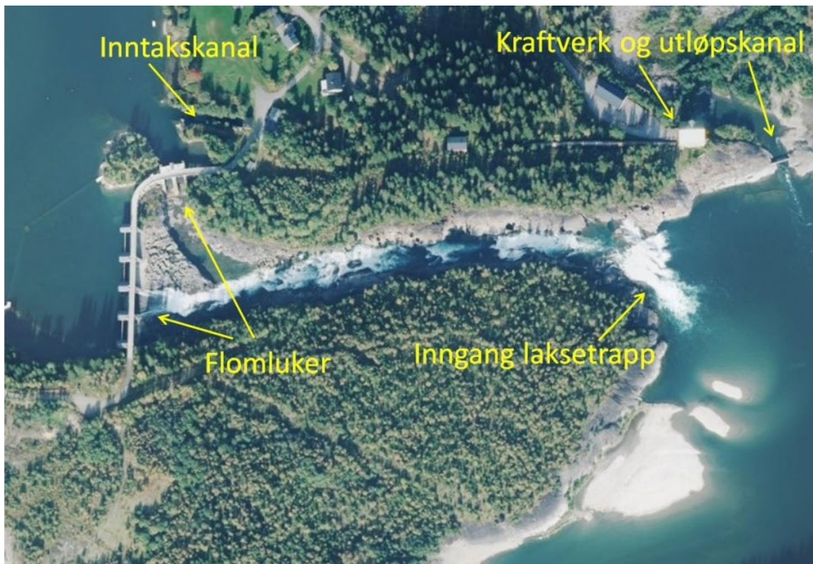
Figur 26. Oversiktsbilde over Reinforsen og Reinforsen kraftverk med lokalisering av munningen til fisketrappa som ble etablert på 1950-tallet. Figuren er hentet fra Fjeldstad & Kraabøl (2016).
