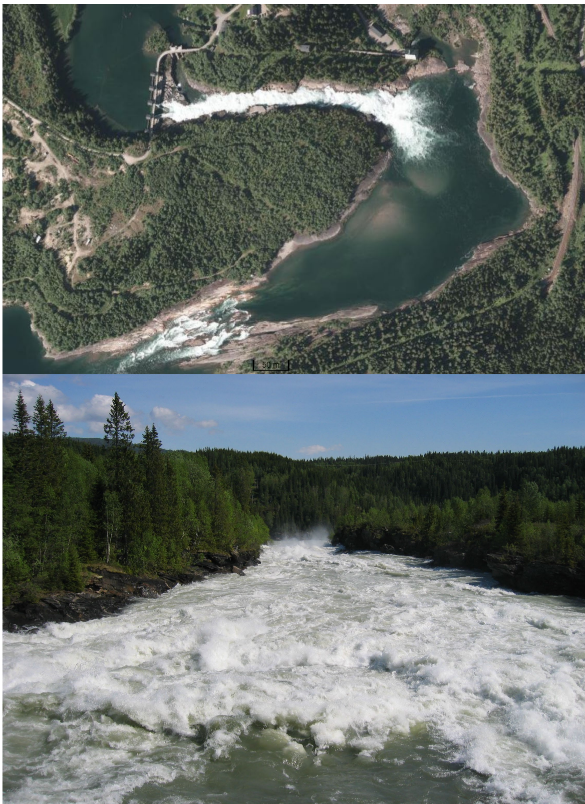
Bildeserie 10. Reinforsen i periode med stort overløp i flomlukene i Reinforsdammen (øverste bilde), og Reinforsen under flomforhold sett fra broa over Reinforsdammen (nederste bilde). Vannføringen var om lag 145 \text{ m}^3/\text{s} da flyfotoet ble tatt i slutten av juli 2019, og om lag 880 \text{ m}^3/\text{s} da bildet ble tatt i midten av juni 2005. Under slike vannføringsforhold er det trolig høyest overlevelse hos fisk som slipper seg ned det naturlige elveløpet. Flyfoto: www.norgebilder.no . Foto: Håvard Lo. Vannføring: www.sildre.nve.no .
