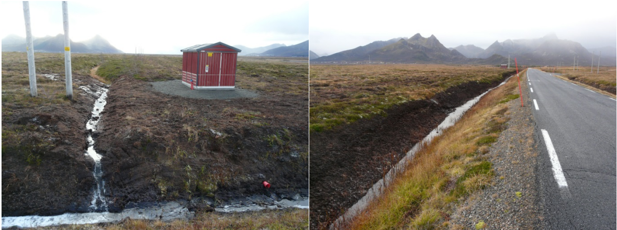
Tekniske inngrep: Koblingshus til jordkabel og fylkesvei med grøfting.
