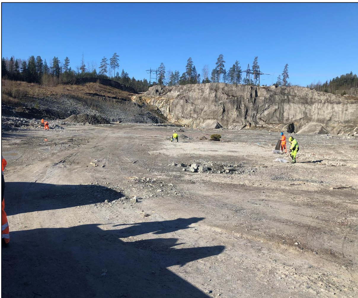
Figur 3. Bilde som viser dagens situasjon ved "Low Area" tatt av entreprenør Hæhre Isachsen 26.04.23. Hauger i bakgrunnen er tetning mot tunnelåpninger.
