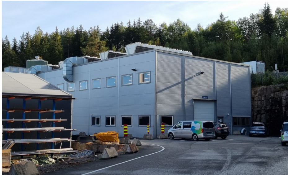
Figur 6 Kjølebygg med ventilasjonsavkast og tørrkjølere
