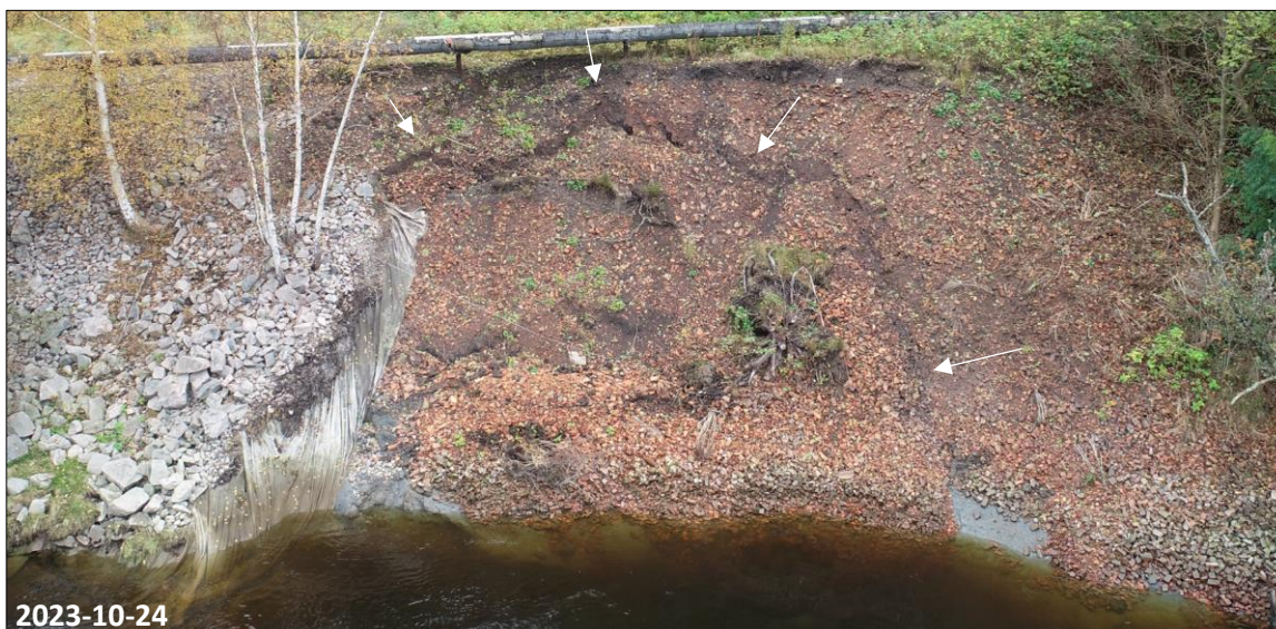
Figur 3.16: Dronefoto vinkelrett på erosjonssår nr. 2 ved ca. 800 m 3 /s vannføring i Glomma, som viser videre oppsprekking.
