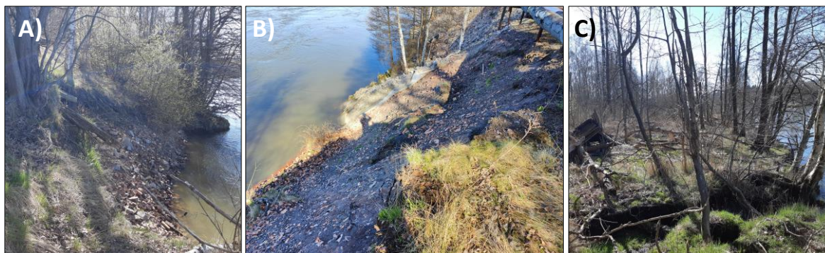
Figur 3.8 – Befaring 21.04.2023 som viser A) «Erosjonssår 1», B) «Erosjonssår 2» og C) «Erosjonssår 3».
