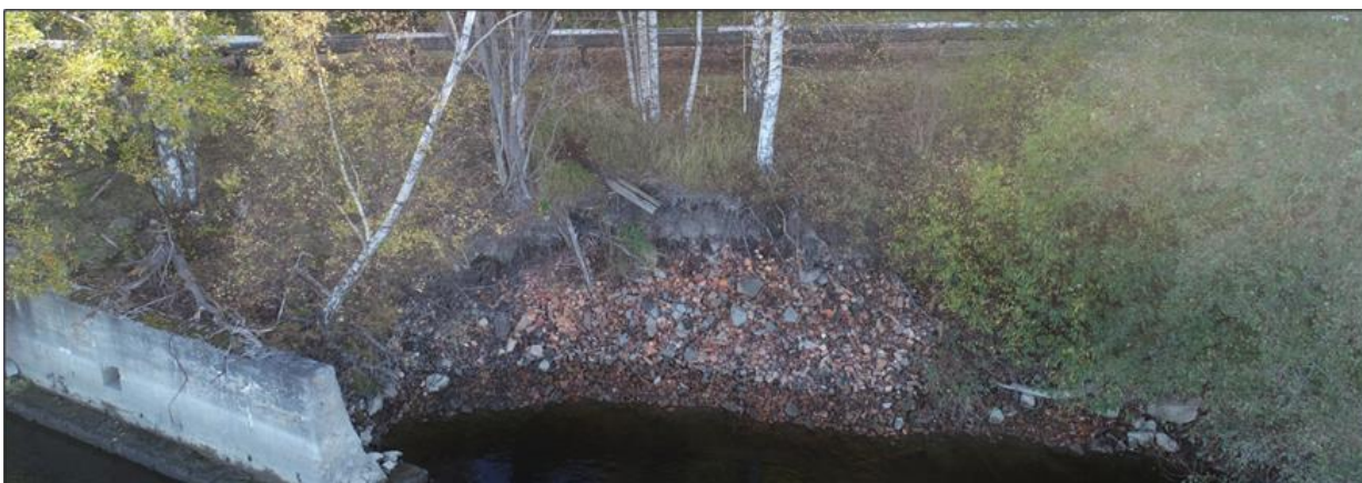
Figur 6-3. Dronebilde av erosjonssår nr. 1 ved ca. 800 m 3 /s vannføring i Glomma.
