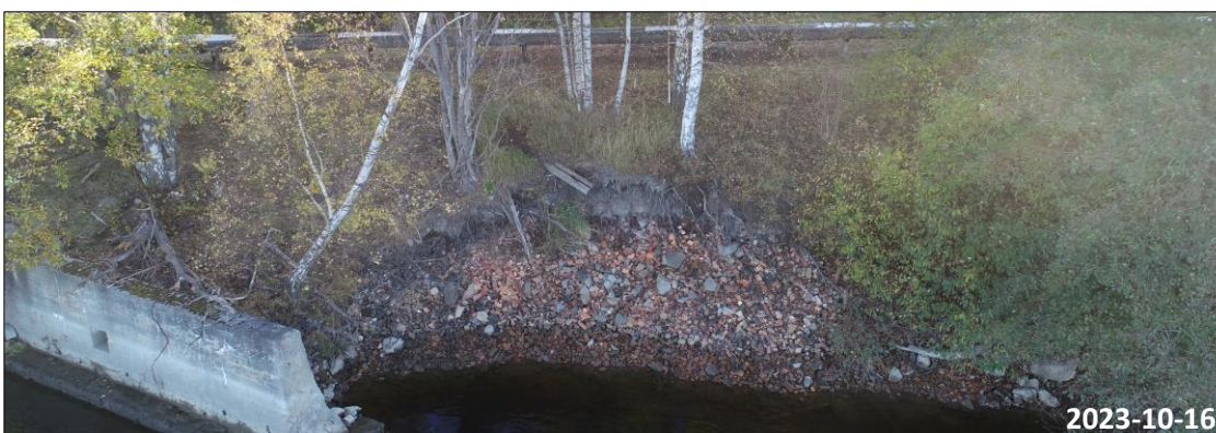
Figur 3.11: Dronefoto vinkelrett på «erosjonssår nr. 1» ved ca. 800 m 3 /s vannføring i Glomma.
