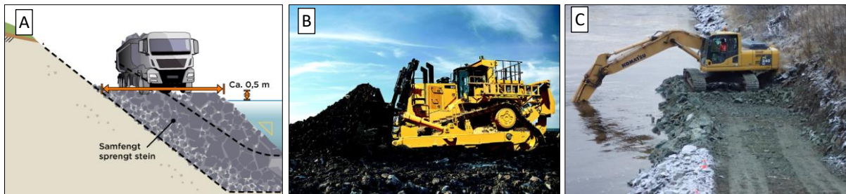
Figur 6-7. Midlertidig anleggsvei for etablering av landplastring. Kilde: Sikringshåndboka til NVE.
