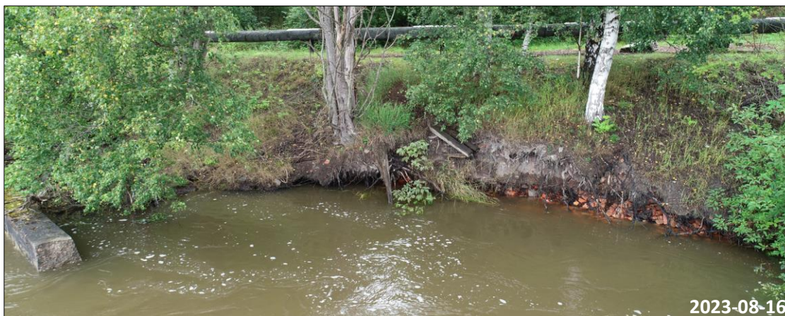
Figur 3.10: Dronefoto vinkelrett på «erosjonssår nr. 1» ved ca. 2800 m 3 /s vannføring i Glomma.
