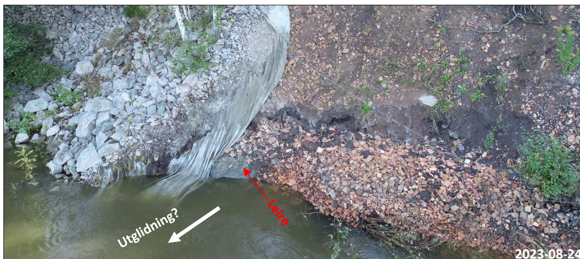
Figur 3.17: Dronefoto (nærfoto) vinkelrett på erosjonssår nr. 2 ved ca. 2200 m 3 /s vannføring i Glomma.
