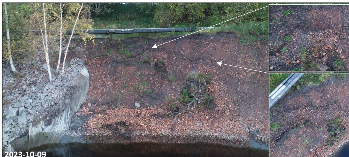
Figur 3.15: Dronefoto vinkelrett på erosjonssår nr. 2 ved ca. 900 m 3 /s vannføring i Glomma, som viser tydelig oppsprekking.
