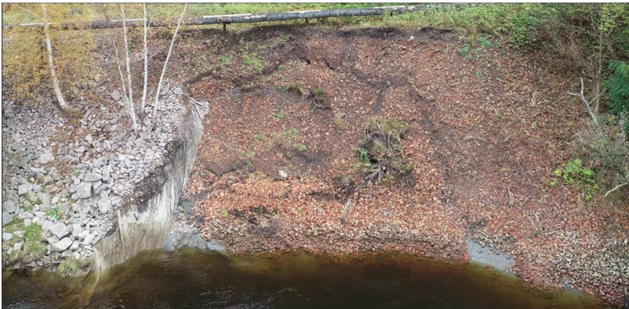
Figur 6-2. Dronebilde av erosjonssår nr. 2 ved ca. 800 m 3 /s vannføring i Glomma.
