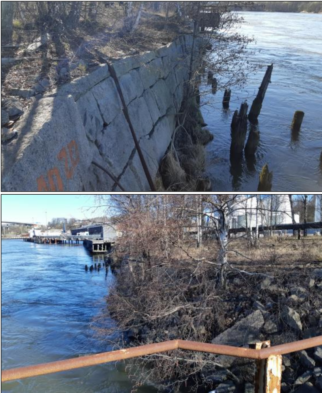
Figur 6-1. Eksisterende kantsone består i dag av tørrmur (øverste bildet) og eksisterende erosjonssikring (nederste bildet).
