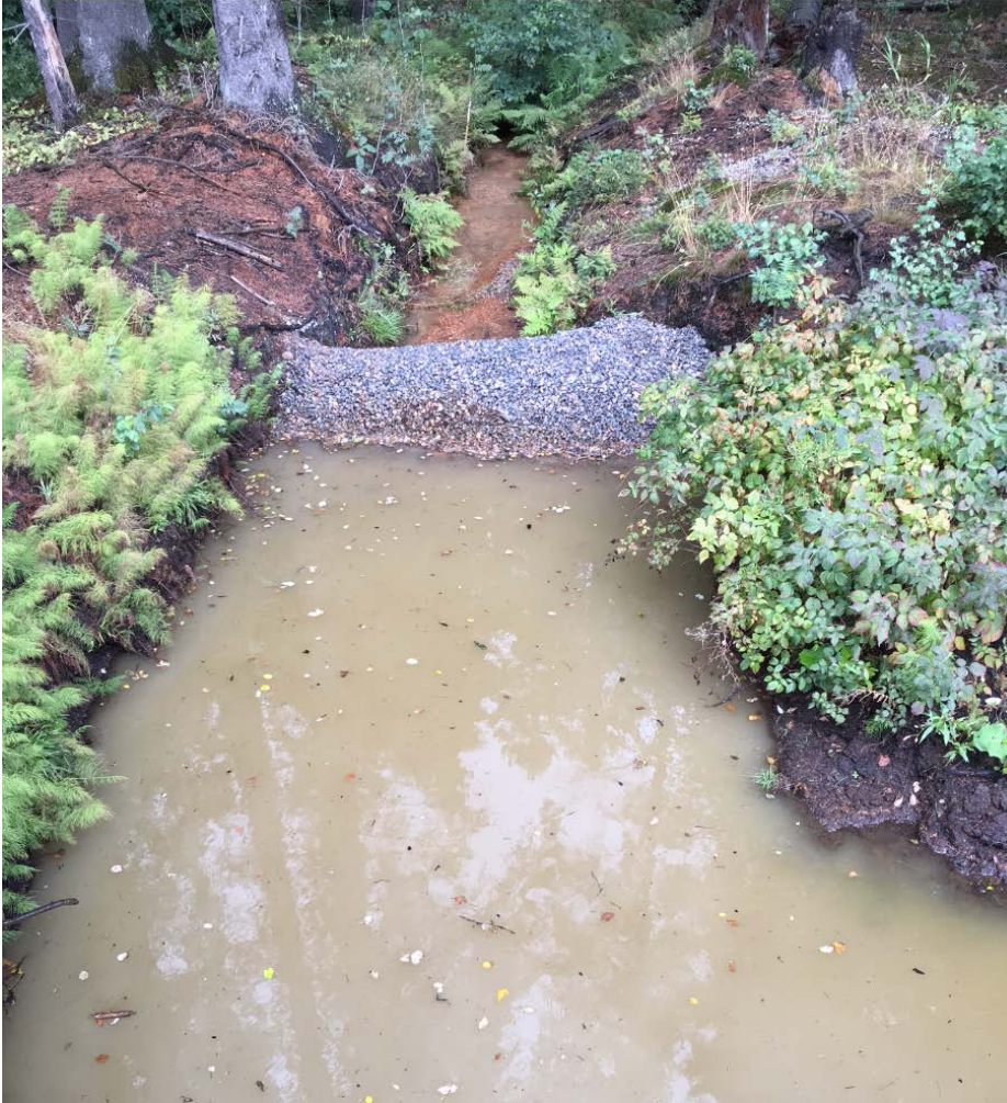
Figur 12: Voll med rensmasser i bekken ut fra lerduebanen ved Foksrød
