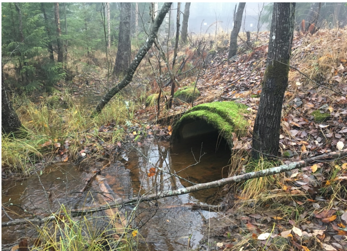
Figur 15. Drensøret mottar vann fra fire inntakskummer plassert på de vestre skytebanene samt en inntakskum ved rensedam 1.
