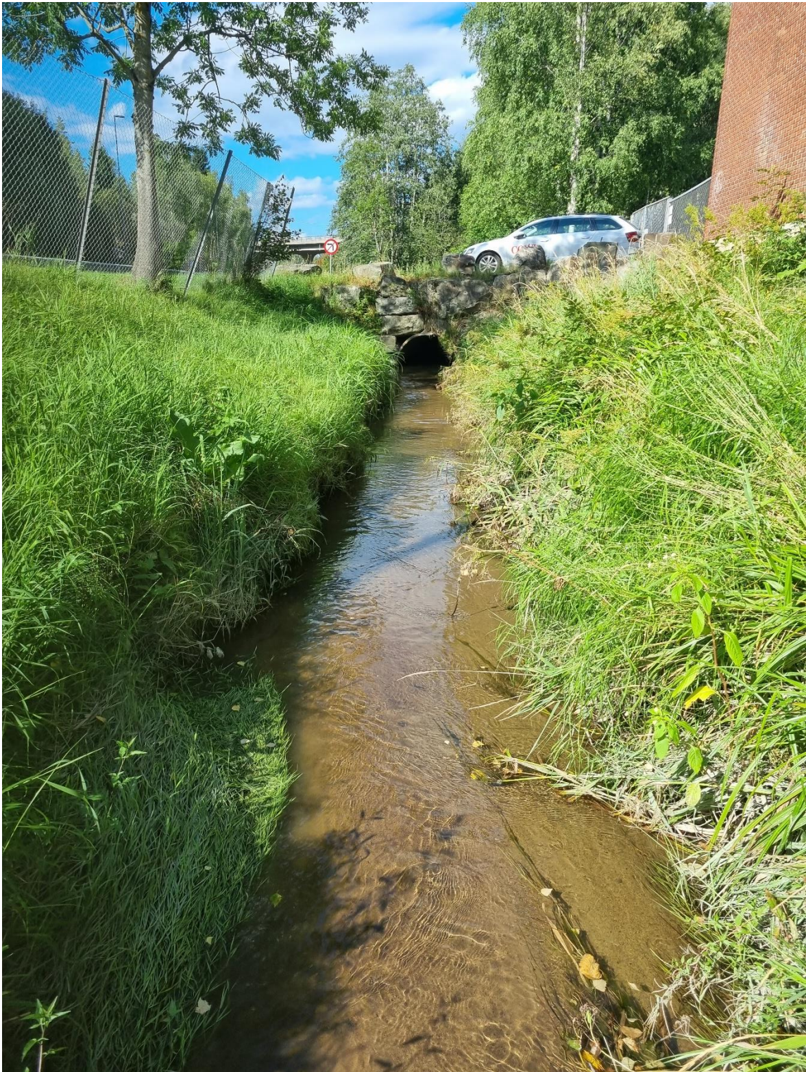
Figur 6-5- Bekkeløpet, innløp til kulvert 2.
