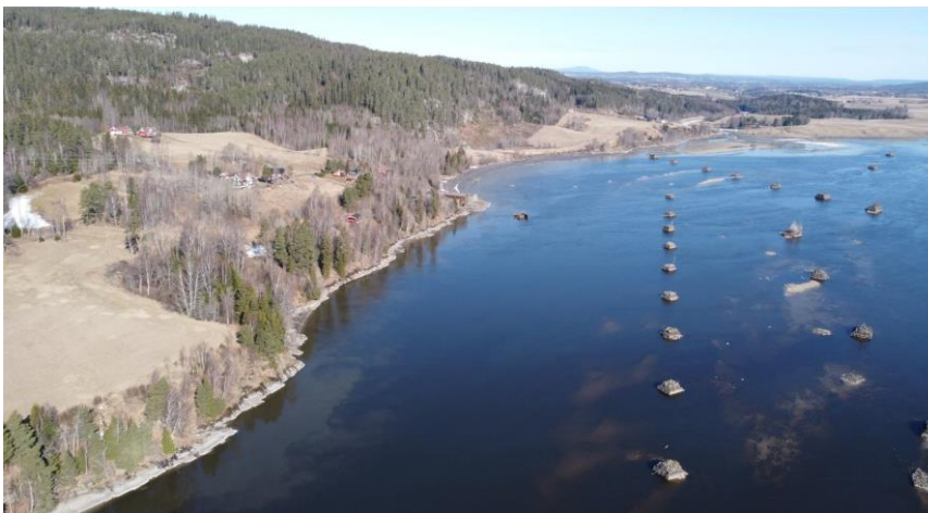
Figur 22 Skråfoto fra sør viser anlegget på avstand
