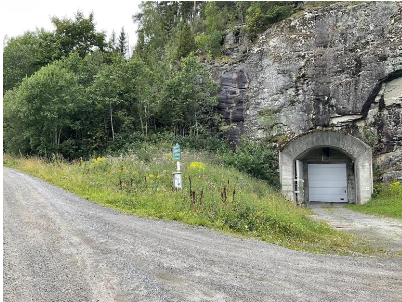
Figur 19 Dagens situasjon sør for adkomsttunnelen til PV1 hvor et eventuelt reservestrømsaggregat vil komme.
