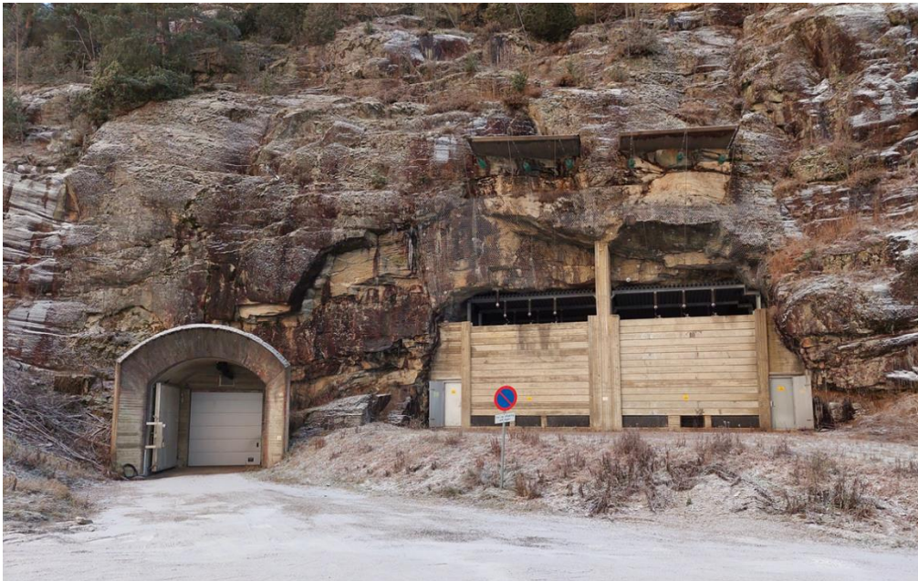
Figur 25 Eksisterende tunnelportal og kraftanlegget i fjellveggen langs Hamerveien nord for daganlegget.
