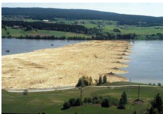
Figur 1-3. Stengerekka eller Tikarsrekka mellom Vestby og Hammeren, ved Fiskeberget, består av 10 lensekar med dobbeltlenser imellom. Her ble tømmeret holdt tilbake og sendt i daglige porsjoner på ned til lensearbeiderne ved sorteringa i Fetsund. Kilde: Bingen lenser. Foto: Dag Nordsveen.
