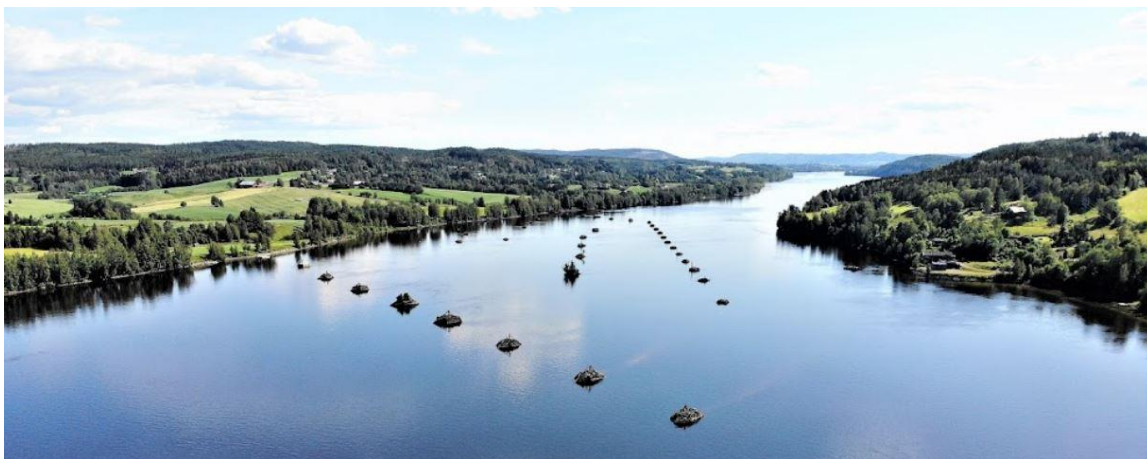
Figur 14 Utsyn sørover Glomma. Damanlegget på Hammeren til høyre i bildet.
