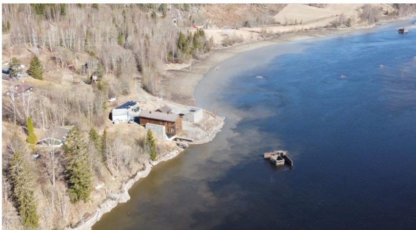
Figur 23 Skråfoto av anlegget sett fra sør
