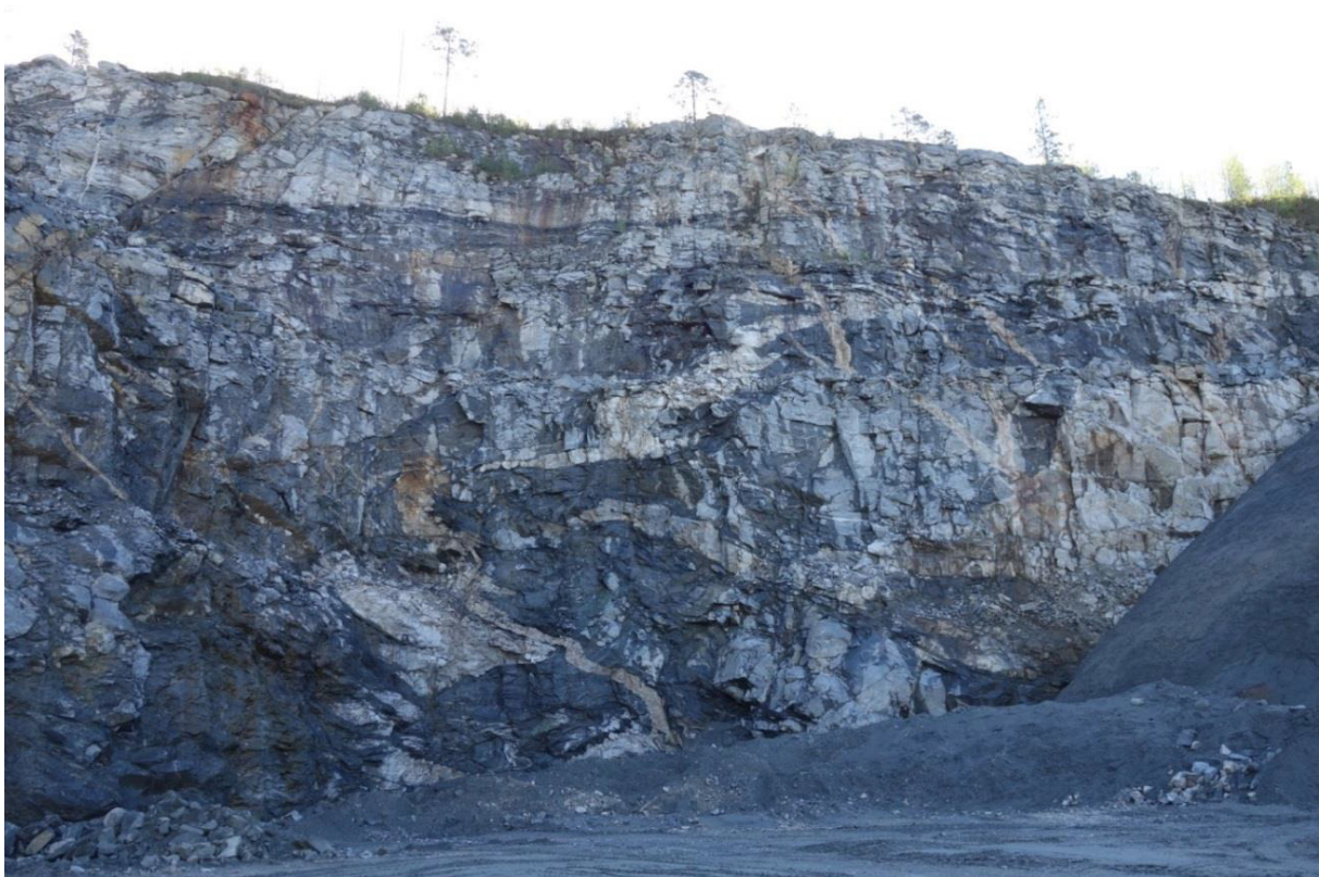
Bildet viser fjellets gneisstruktur og oppsprekkingsgrad. Fjellskjæringen er relativt tørr uten sprekker med observert vannføring.
