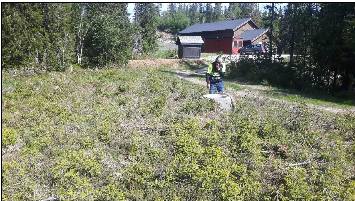
Figur 26: Vegglifjell renseanlegg sett fra infiltrasjonsbassengene i sør.
