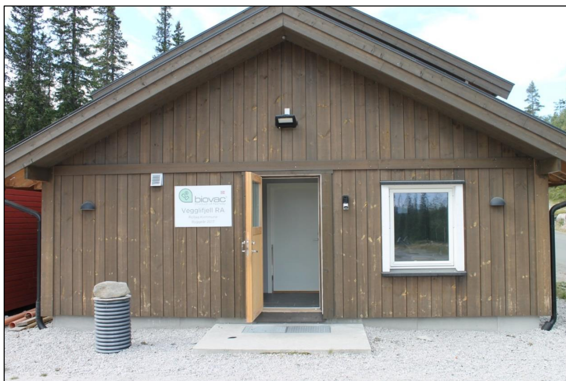
Figur 24: Vegglifjell renseanlegg, inngangsparti.
