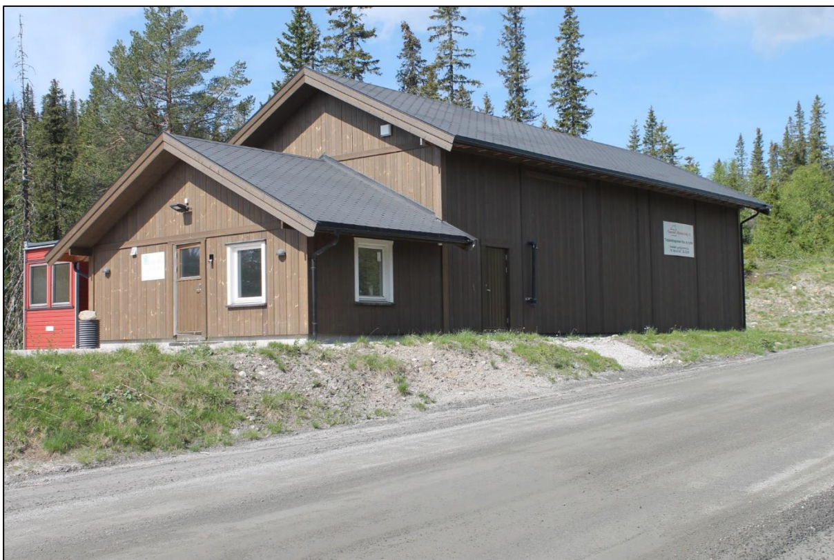
Figur 25: Vegglifjell renseanlegg sett fra Vegglifjellvegen i øst.
