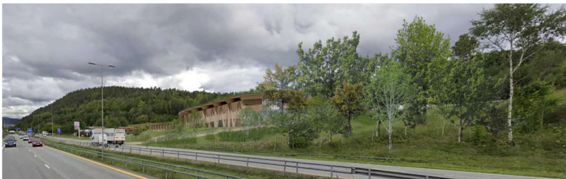
Figur 6 Gjenvinningsanlegget på Eikhaugen sett fra E18 nordover mot Nordbyåsen.
