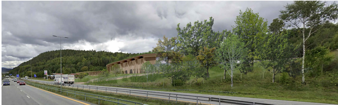
Anlegget sett fra E18 nordover mot nordbyåsen
