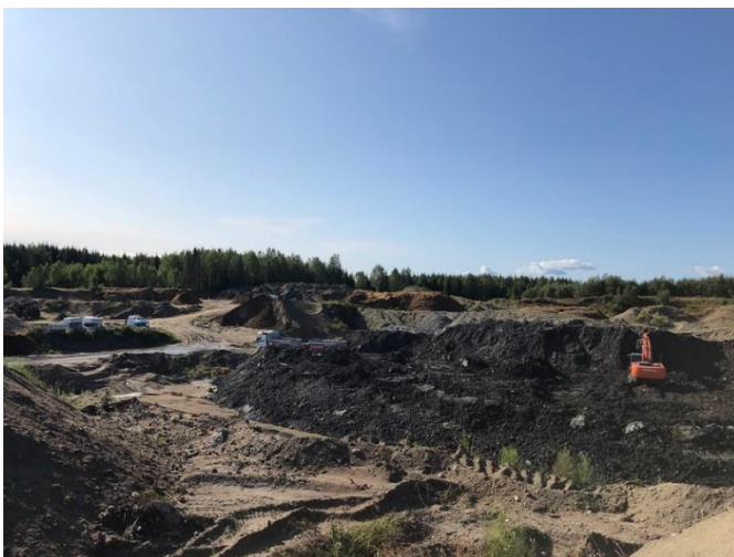
Figur 5 Sett sørover fra målepunkt M3. Gravemaskin i forgrunn, siktemaskin i bakgrunnen.
