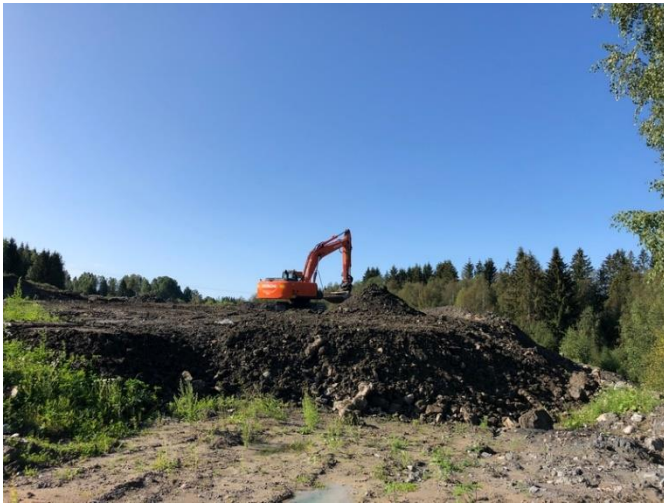
Figur 4 Gravemaskin ved målepunkt M1
