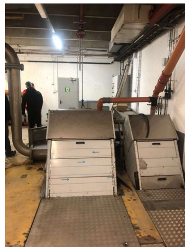
Figur 15: Eksisterende innløpsrister.
