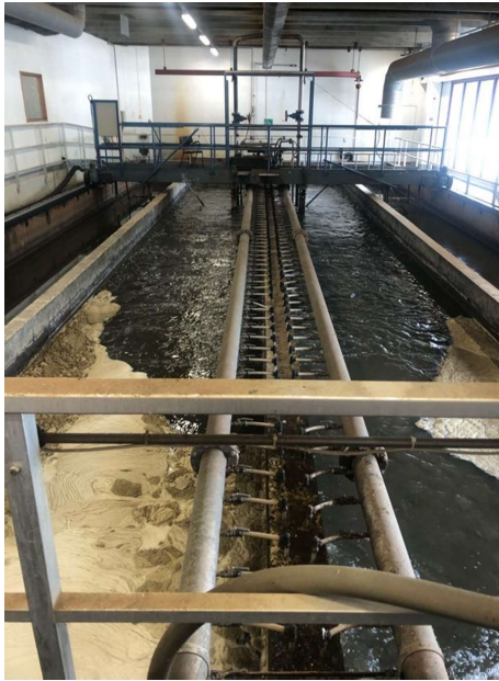
Figur 16: Eksisterende sand- og fettfang.
