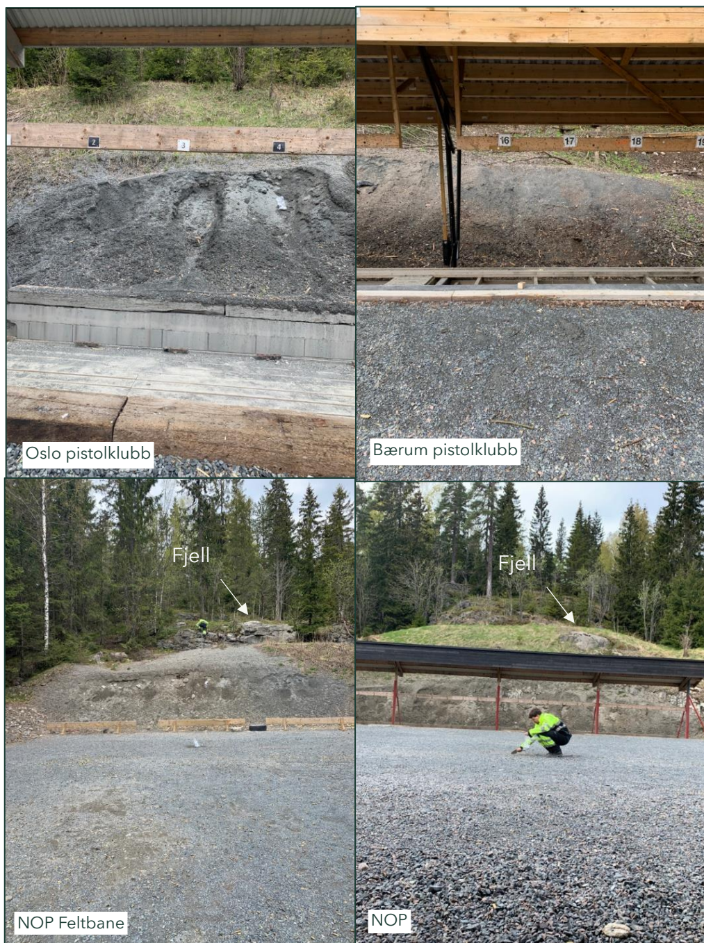
Figur 48. Baneløp og voller ved pistolbanene består av siltige masser med varierende innhold av stein. I baneløpene er det lagt på et lag med pukk over siltige løsmasser. Det er lagt på subbus foran kulefangervollene. Terrenget bak skivene er bratt, og stedvis er det fjell i dagen. I overkant er det skogsterreng.
