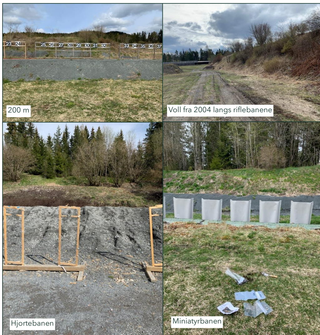
Figur 42. Området med aktive rifle-, kortholds- og feltbaner er bygget opp av fyllmasser med antatt varierende opprinnelse. Fyllmassene ligger både i baneløp og i skjermede voller. Overflateprøver viser at de består av sandig silt med varierende innhold av pukk, stein og mursteinsfragmenter. Skivevoller og kulefangere er bygget opp med kombinasjoner av subbus, bark, stedlige masser av sandig morene eller tilkjørte fyllmasser med sandig silt og stein.
