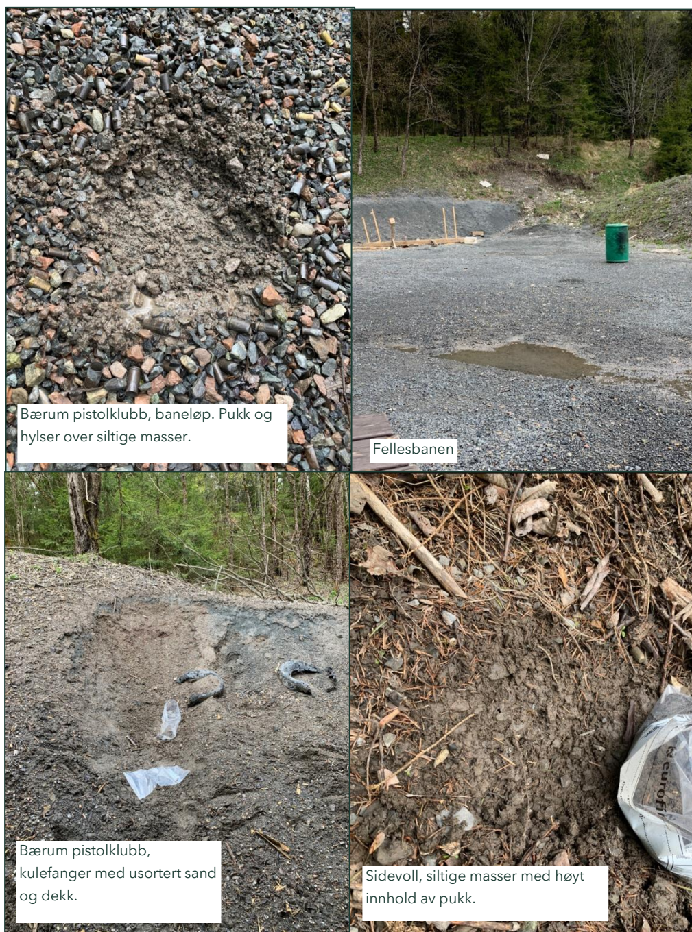
Figur 49. Baneløp og voller ved pistolbanene består av siltige masser med varierende innhold av stein. I baneløpene er det lagt på et lag med pukk over siltige løsmasser. Det er lagt på subbus foran kulefangervollene, på banen til Bærum pistolklubb er det også lagt dekk i kulefangervollen.
