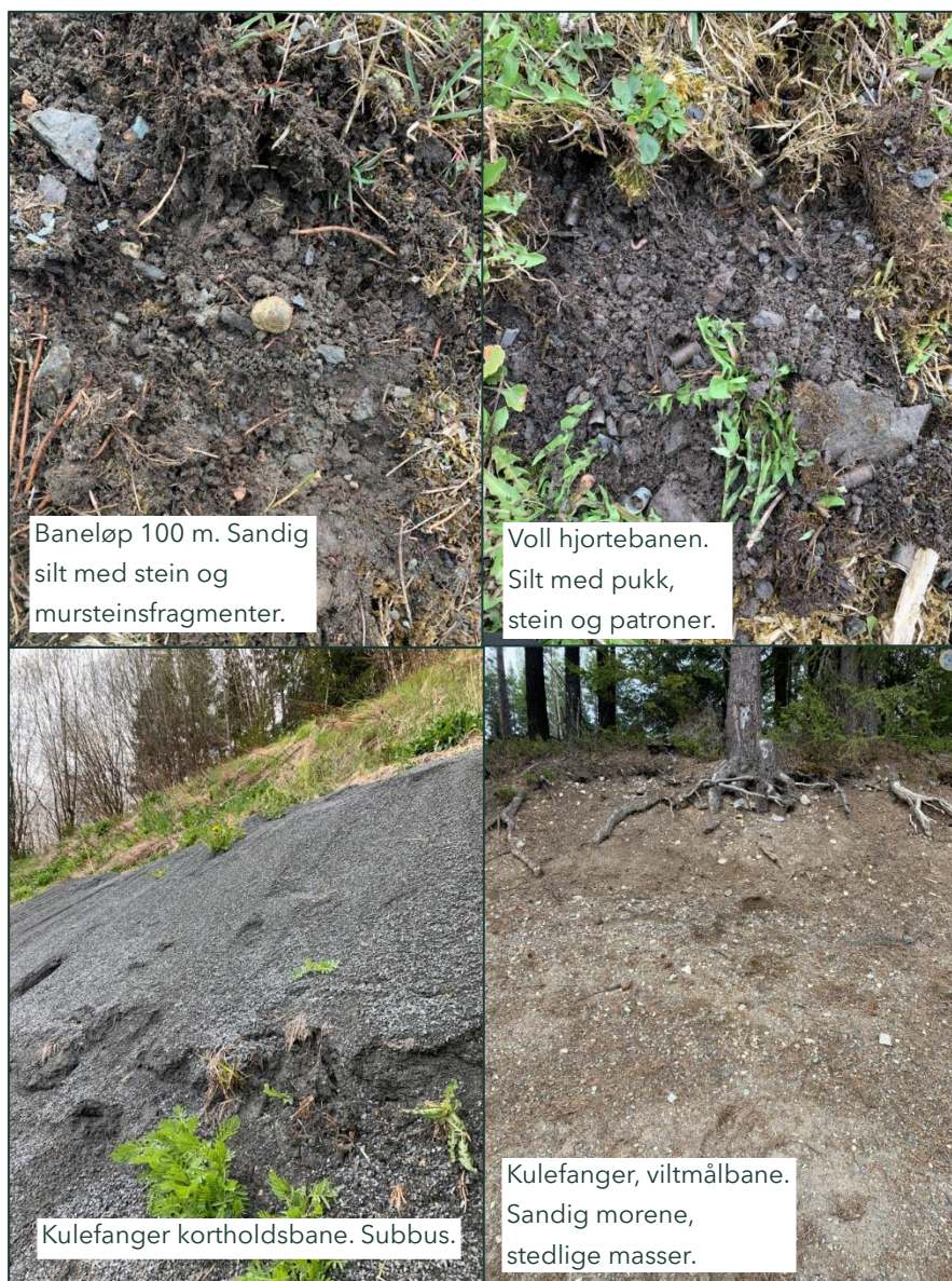
Figur 43. Baneløp og voller på rifle-, kortholds-, og feltskytebanene består av sandig silt med varierende innhold av pukk, stein og mursteinsfragmenter. Skivevoller og kulefangere er bygget opp med kombinasjoner av subbus, tilkjørte masser med sandig silt og stein, bark, stedlige masser av sandig morene.
