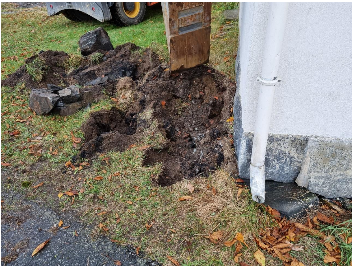
Figur 14: Prøvegraving ved Varmbadet.
