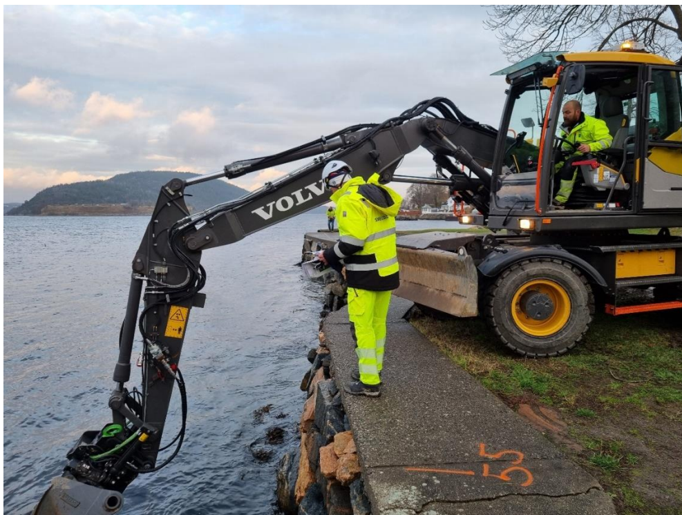
Figur 2: Registering av dybde til berg med gravemaksinskuff.
