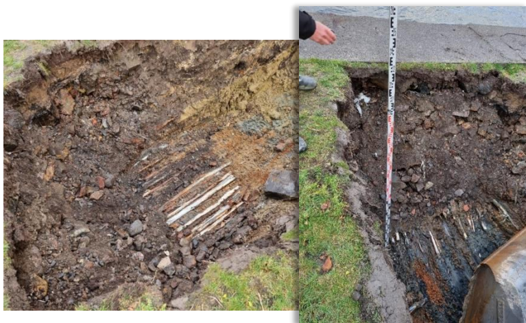
Bilder av trerester bak støttemuren under prøvegraving.
