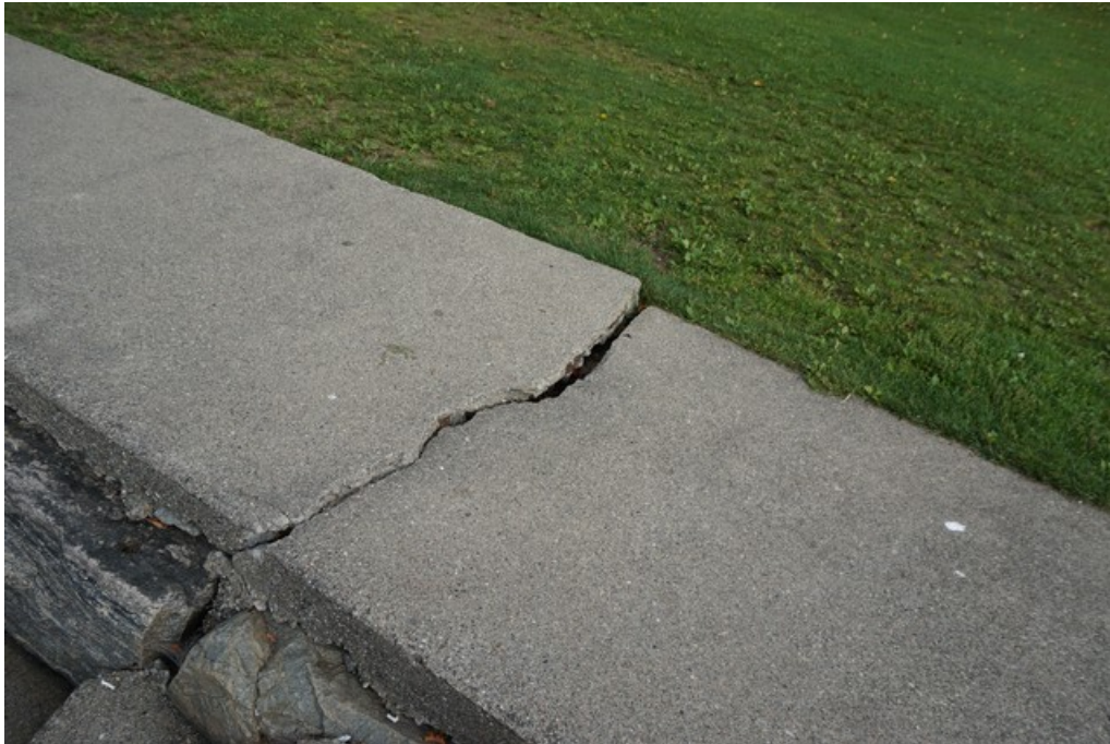
Bilde 7: Slitelag/ betongpåstøp
