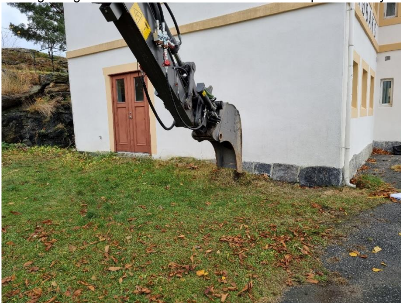
Figur 12: Prøvegraving ved Varmbadet.
