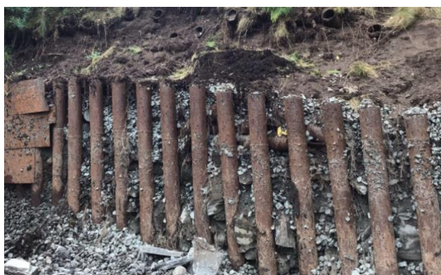
Figur 4-5: Boret rørvegg, illustrasjon.
