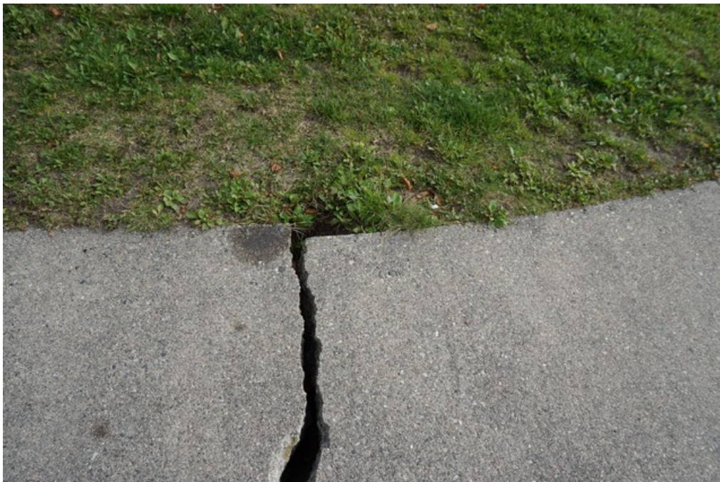
Bilde 8: Slitelag/ betongpåstøp
