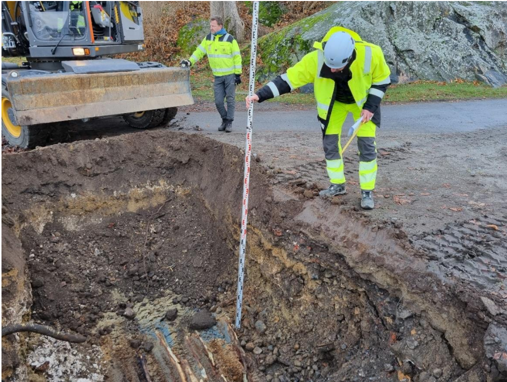
Figur 10: Prøvegrop 6, trevirke i ca. 1,4 m dybde under terreng.
