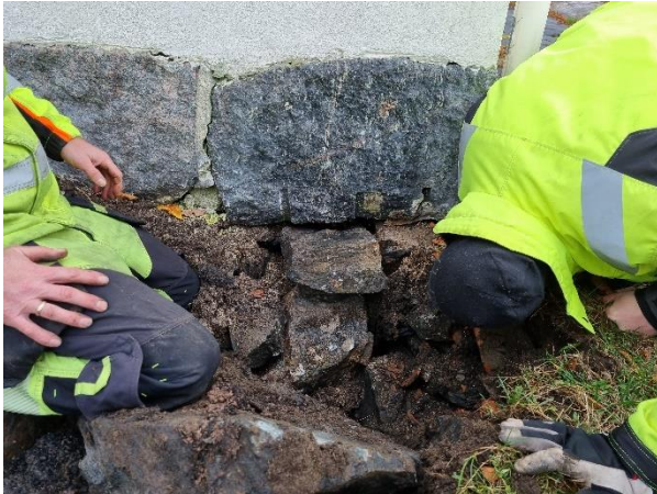
Figur 2-2: Prøvegraving ved nordvestre hjørne av Varmbadet. Steinfylling avdekket under gulvnivå.
