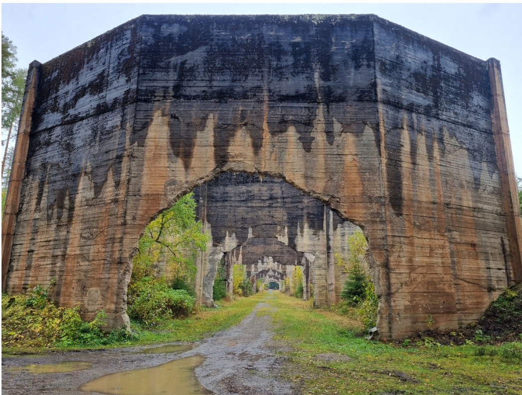
Figur 4 Bilde som viser betongbuene, sett mot standplass. Foto: Multiconsult
