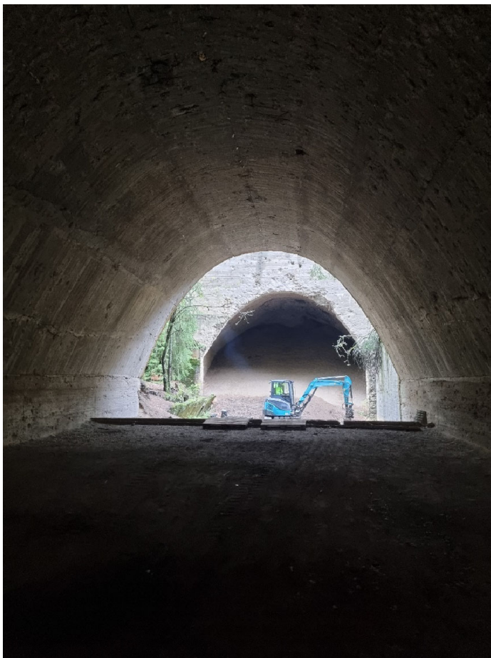
Figur 5 Bilde som viser betongtunnelen og skytevoll. Foto: Multiconsult.
