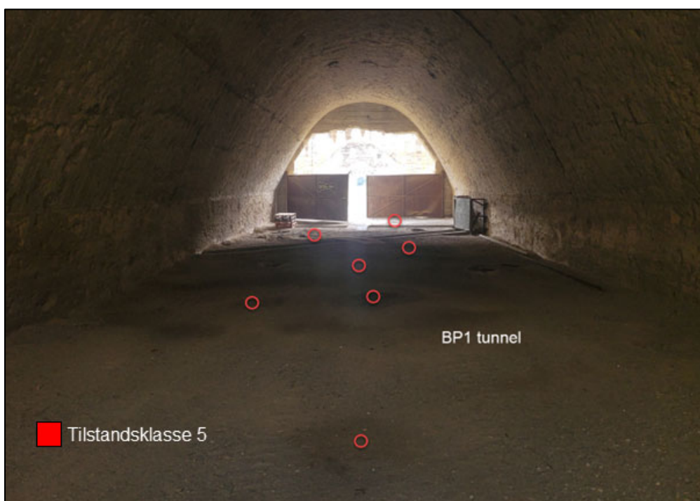
Figur 16. Blandprøven (delprøvene er avmerket med røde sirkler) av overflatemassene i betongtunnel viste tilstandsklasse 5 mht. bly. Nær porten er en av de to grøftene hvor det har stått bevegelige mål.
